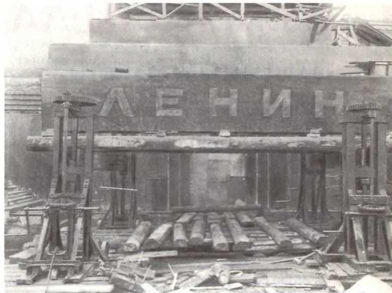
Черный блок с красными буквами ЛЕНИН подняли и установили над входом с помощью домкратов.
