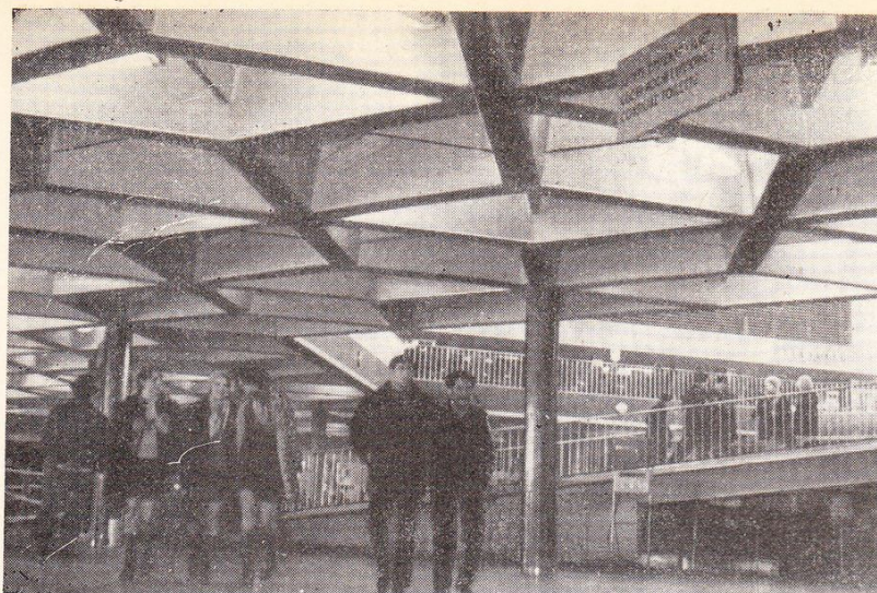
Рис. 3. Бориспольский аэровокзал. Перекрытие в операционном зале
