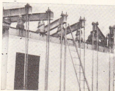
Рис. 3. Общий вид статических испытаний
