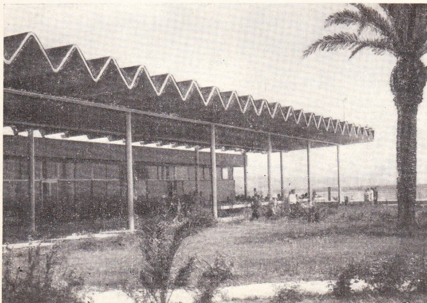
Рис. 5. Перекрытие галереи Морского вокзала в Пицунде
