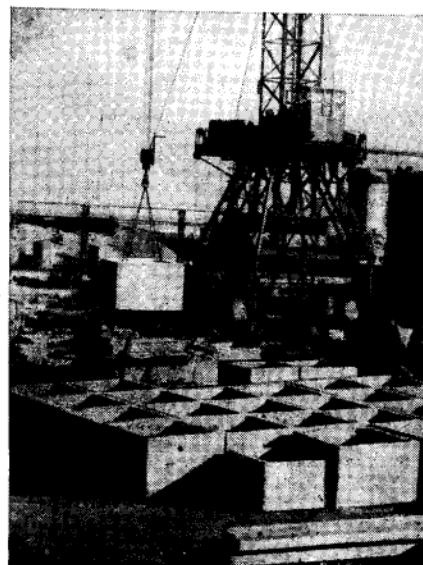
Рис. 1. Изготовление блоков тоннелей на машине МТ на Днепропетровском заводе «Стройдеталь» треста Днепроспецстрой
