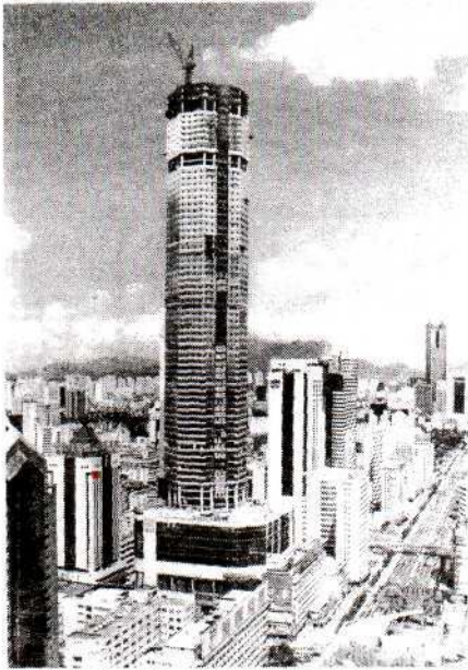
Рис. 4. 72-этажное торгово-административное здание SEG Plaza (г.Шинциэн) высотой 291,6 м
