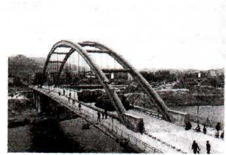
Рис. 5. Трубобетонный арочный Ванчан мост пролетом 115 м через р.Донхэ
