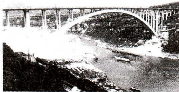
Рис. 6. Ваньсянь мост (г.Чунцин) шириной 24 м пролетом 420 м через р.Янцзы
