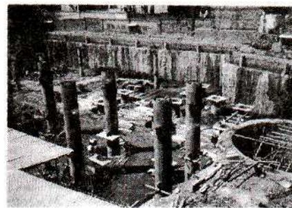
Рис. 2. Процесс возведения подземной части трубобетонных колонн здания Peace World Plaza методом обратного хода
