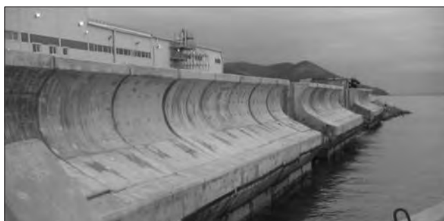
Рис. 4. Волноотбойная стенка из сборных железобетонных блоков массой 40 т (объект К3-2, табл. 1)
