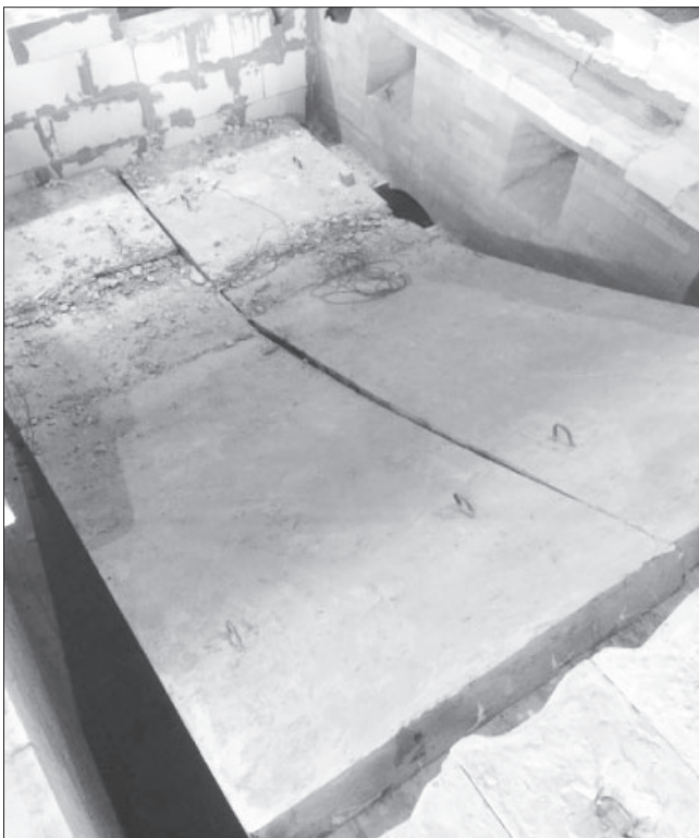
Рис. 11. Характерный вид плит серии Б после обрушения в пространство печи и после охлаждения Fig. 11. Characteristic view of series B slabs after collapse into the furnace space and after cooling
