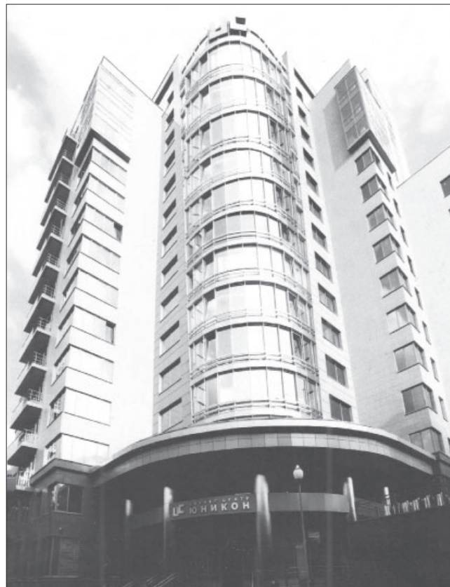
Здание офисно-лабораторного корпуса института «ВНИИжелезобетон» (Москва, ул. Плеханова, 4)
