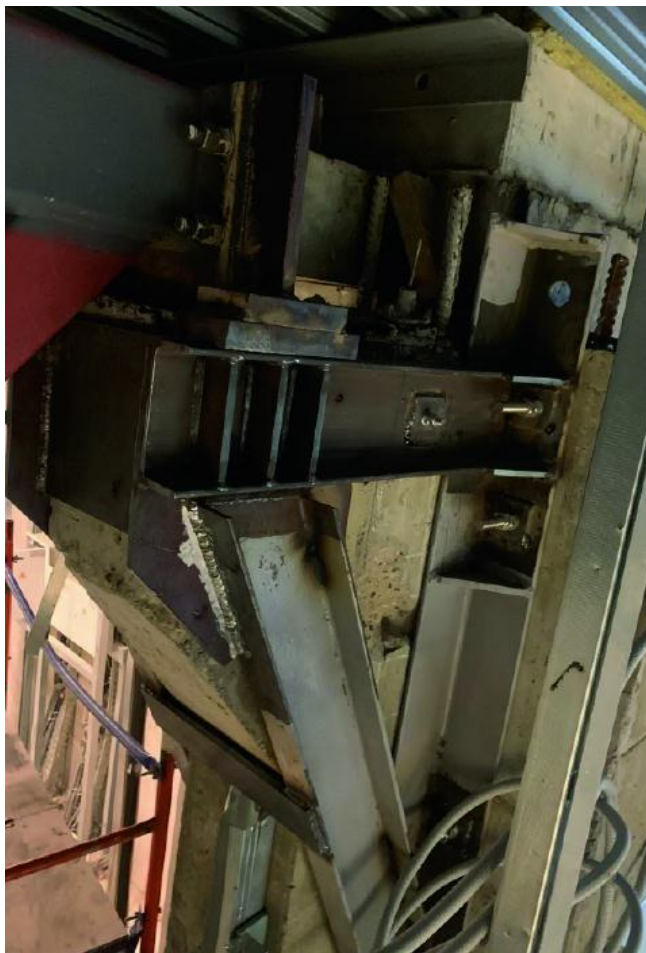
Рис. 12. Реализация проектной конструкции усиления коротких консолей железобетонных пилонов Fig. 12. Implementation of the design of short consoles of reinforced concrete pylons reinforcement
