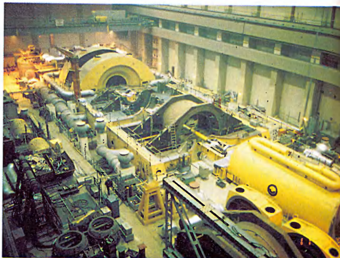
Строительство атомной электростанции. Котел реактора (верхний слева) перевозят на стройплощадку (нижний слева). Справа наверху помещен обзорный снимок машинного зала с турбинами и генератором.
