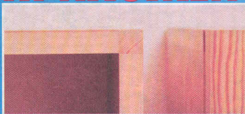
Видимые торцы заготовок шкафа фанеруются перед сборкой шкафа. Бруски угловых соединений, которые несколько выступают после сборки шкафа, строгаются до нужного размера.
