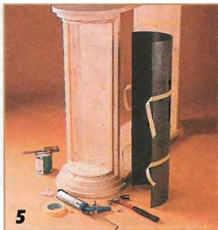
5 Прежде чем приклеить половинки труб, их дважды зашкуривают, шлифуют и покрывают лаком желаемого тона.
