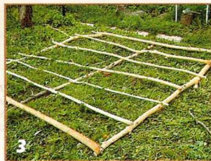
3 Две самые большие заготовки для каркаса — боковые стенки, собирал прямо на земле.
