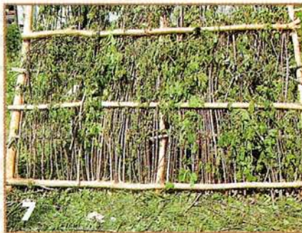
Вплетая ветки кровли, заводил их между перекладинами так, чтобы ошкуренные перекладины обрешетки оставались снаружи, а неошкуренные — внутри шалаша.
