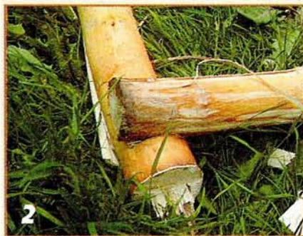
2 При сборке каркаса все соединения собирал на гвоздях, предварительно вырезав на концах небольшие лунки.
