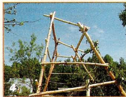
4 Обе заготовки боковых стенок поставил вертикально на расстоянии примерно 2,2 м одну от другой и перевязал их поверху тремя перекладинами длиной по 700 мм.
