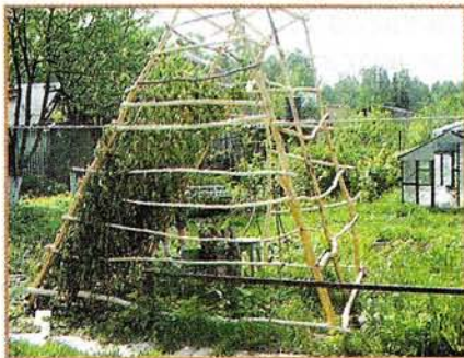
С одной стороны торцевой проем зашил обрешеткой из горизонтальных перекладин, прибитых с шагом 500-600 мм,...
