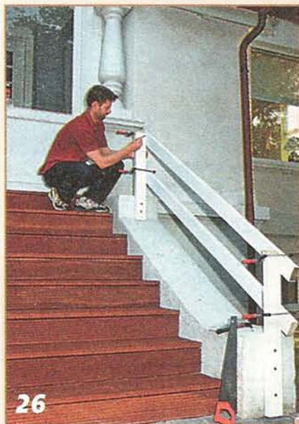
С наружной стороны к стойкам крепят струбцинами продольные связи, которые также помечают линиями реза.
