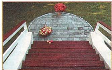
Рис. 1. Доски крепят к бетонным ступеням на дюбелях и шурупах.
