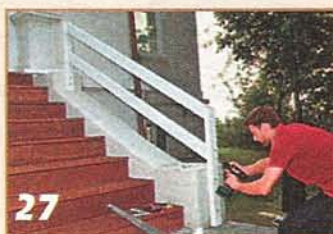
Раскроенные по длине продольные связи привинчивают к стойкам.
