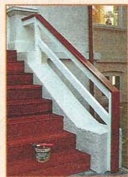
Сверху к верхним продольным связям и нижним брусьям крепят шурупами поручни. Спереди к нижним стойкам привинчивают фасадные накладки.
