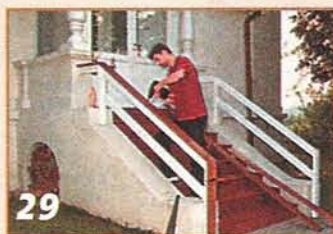
Сверху к верхним продольным связям и нижним брусьям крепят шурупами поручни. Спереди к нижним стойкам привинчивают фасадные накладки.
