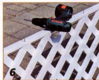
Решётки скрепляют со стойками А, В и С.
