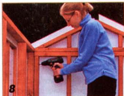
Начинают сборку домика с крепления одной из боковых стен к задней.
