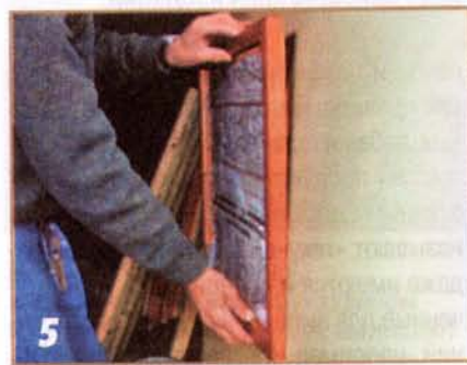
5 Подгоняют оконную раму к проёму.
