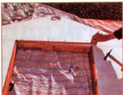
Вход окантовывают штапиком.
