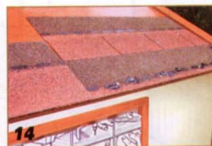
Вдоль нижней кромки крепят первый ряд плитки.
