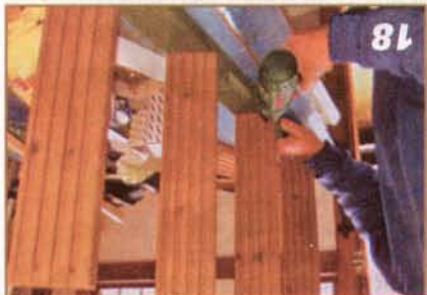
18 Доски обшивки балкона устанавливают с одинаковым шагом с помощью маленьких проставок из фанеры.
