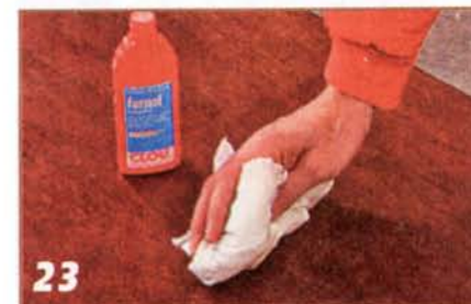
23 Проверив политуру на её совместимость с другими возможными покрытиями, её наносят на поверхность и дают короткую, в две-три минуты, выдержку.
