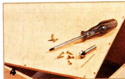
4 Сверлят и раззенковывают отверстия под шурупы в задней стенке, которую вставляют в фальцы заподлицо с остальными деталями корпуса и крепят шурупами.
