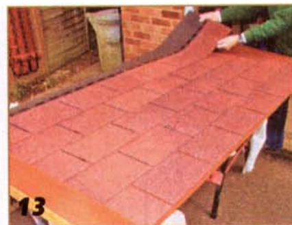
Плитки проще вырезать до установки секций крыши.
