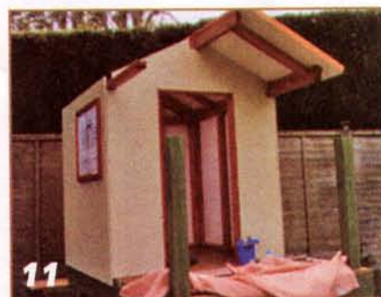
Для монтажа крыши нужны два человека.
