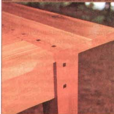
Гарнитур для открытого воздуха сделан из хвойной древесины на полиуретановом клее и отделан специальными водостойкими составами.
