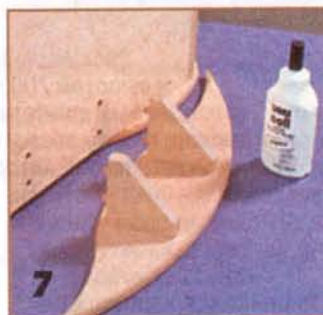
С тыльной стороны фигурного карниза на шкантах с клеем крепят опорные рёбра, которые приклеивают к верхнему горизонтальному щиту.
