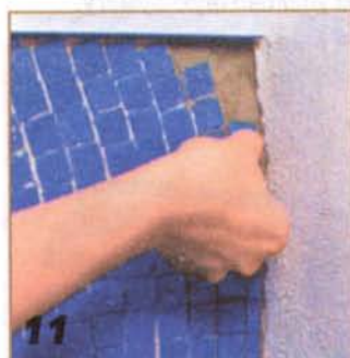
11 Не доведя работу до конца, экран крепят шурупами к раме из брусков под ванной, после чего приклеивают к нему остальные плитки.
