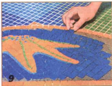
9 Последними кладут недостающие плитки, вплоть до ранее выложенной окантовки. Крайние кусочки подгоняют, ломая их щипцами.
