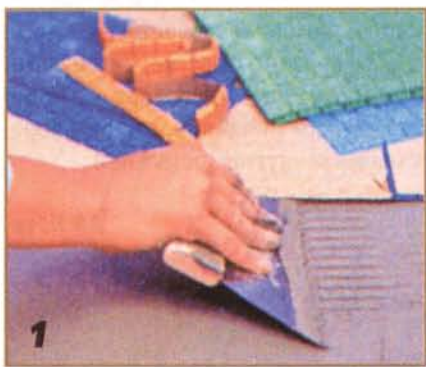
1 Разноцветные прямоугольные и квадратные мозаичные карты кладут бумажным слоем вверх на клей, нанесённый на основу зубчатым шпателем.
