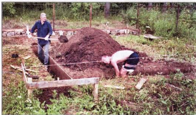
Траншея под фундамент
