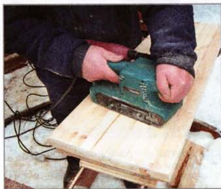
Заготовки отторцевали и зачистили. Лицевые кромки скруглили фрезерованием
