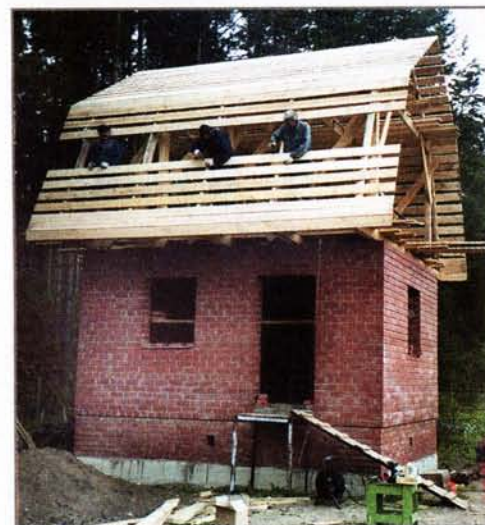
Работа по набивке обрешётки близка к завершению
