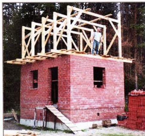
П-образные рамы несущей конструкции ломаной крыши установлены и зафиксированы технологическими связями
