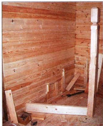
Монтаж лестницы начали с установки опорного столба
