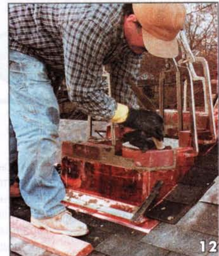
Рис. 5. V-образный вырез в фартуке на коньке
