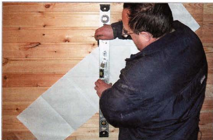
Разметка профиля лестницы на стене требовала точности
