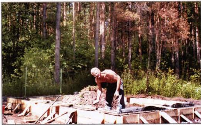
Для заливки надземной части фундамента установили опалубку, верх которой тщательно выверили по горизонтали
