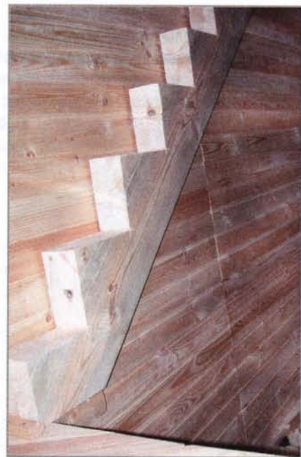
Один косоур прикрепили по разметке к стене,...
