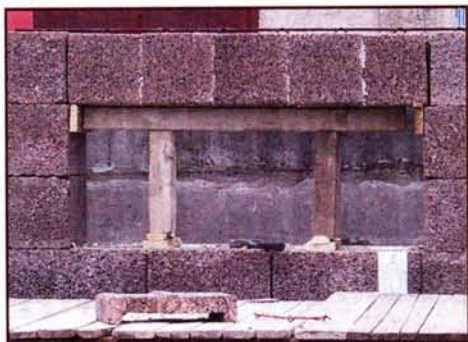
Специальные блоки DURISOL позволяют надёжно перекрывать проёмы в стенах
