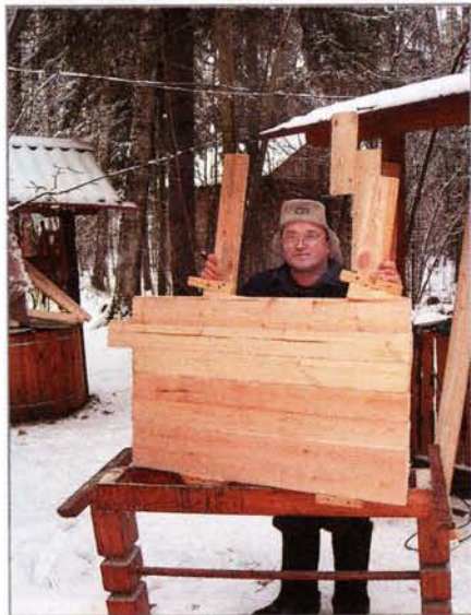
В первую очередь для будущей лестницы подготовили клеёные доски для простых и забежных ступеней
