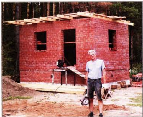
Стены домика выложены и перекрыты балками, на которые уложены доски настила. На этой технологической площадке теперь можно заниматься несущей конструкцией крыши
