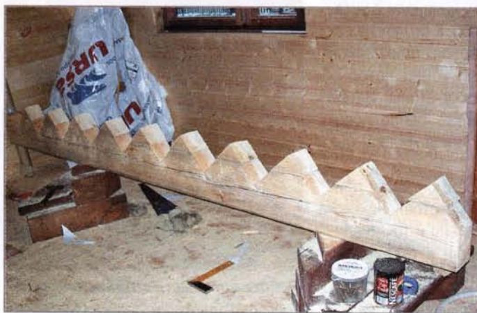
Для прочности приклеили призмы на нужные места и прикрепили саморезами
