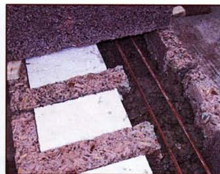
Строительство несущей стены из блоков с утеплительными вставками
