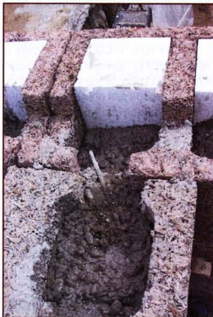
Примыкание внутренней и наружной стен
