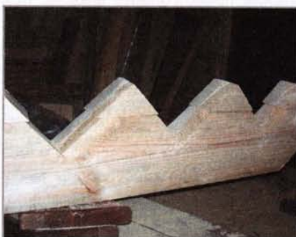
Вершины углов требовалось «нарастить», для чего подошли выпиленные из косоуров призмы
