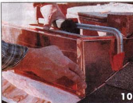
Рис. 5. V-образный вырез в фартуке на коньке
