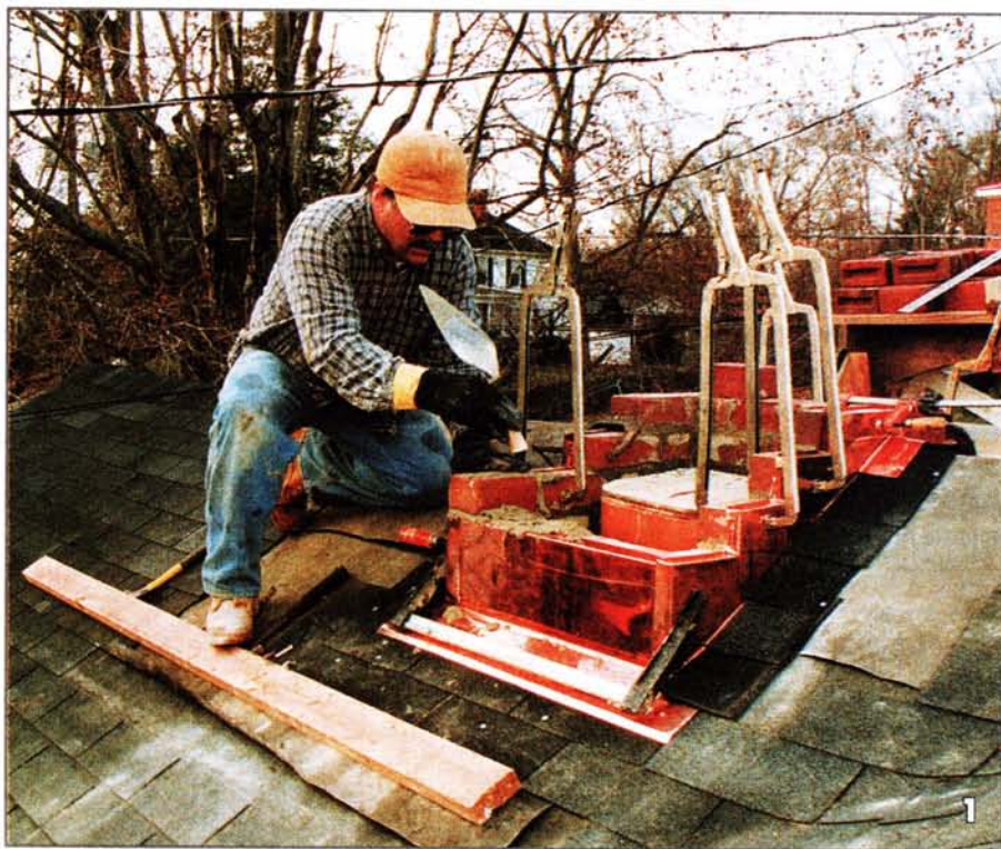
Ступенчатые фартуки. Набор струбцин и зажимов позволяет устанавливать гидроизоляцию одновременно с кладкой дымовой трубы. Сварочные зажимы надёжно фиксируют перекрывающие фартуки на трубе и, в то же время, позволяют продолжать кладку
