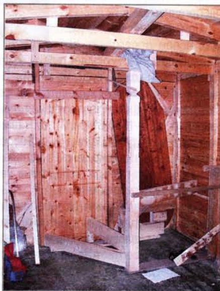
Чтобы убедиться в удобстве забежных ступеней, мы в мастерской собрали макет лестницы в натуральную величину
