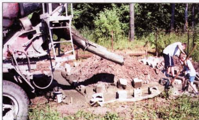
Заливка подземной части фундамента готовой смесью
