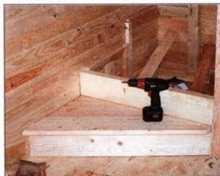
Подступёнки крепили к столбу и брусу на стене
