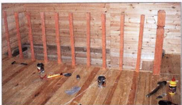
После укладки ступеней мы установили балясины и на них уложили перила
