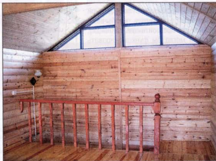
Ограждение лестничного проёма в мансарде
