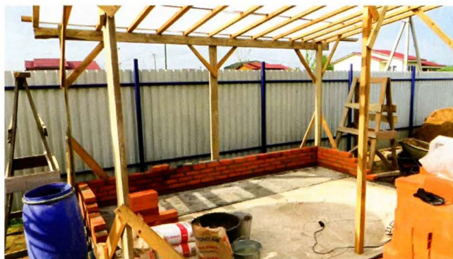
Работу мастер начал с укладки гидроизоляции и разметки прямо на расстеленном полотнище рубероида.
