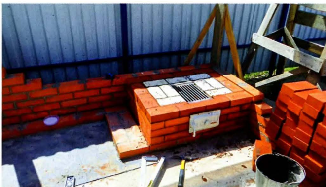
... на 5-м уложен колосник, а на 6-м установлена топочная дверка.
