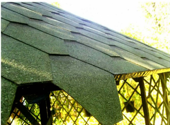
В качестве кровли использована мягкая черепица отечественного производства.
