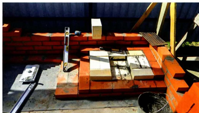
На 2-м ряду выложен зольник и закреплена поддувальная дверка,...
