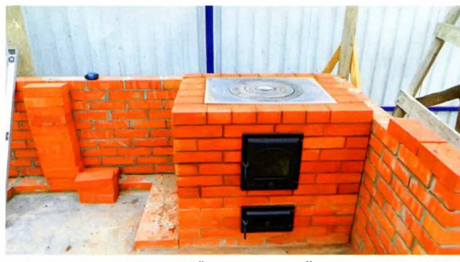
На 10-м ряду перекрыт проём над топочной дверкой, а на 12-й ряд уложена чугунная одноконфорочная плита для казана (710 × 530 мм).
