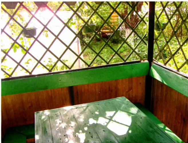
В беседке стол и скамьи для защиты покрыты краской в два слоя.
