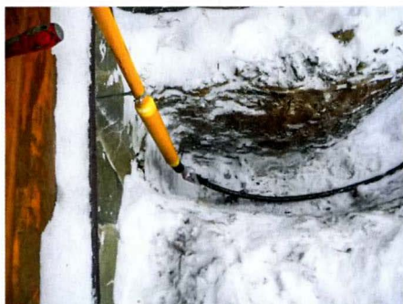
В траншею уложили газопровод из трубы ПНД, вертикальный трубопровод около дома — из стальных газовых труб для пожарной безопасности.
