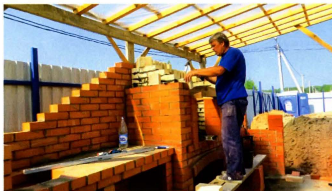
Выкладывая стенки топочной камеры мангала, мастер поднимал одновременно и дымоход печи.
