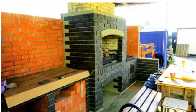
В качестве облицовки комплекса было решено применить тёмную клинкерную плитку под кирпич с угловыми элементами.
