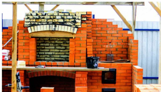
После перекрытия камеры мангала её дымоход был объединён с дымоходом печи в один канал,...
