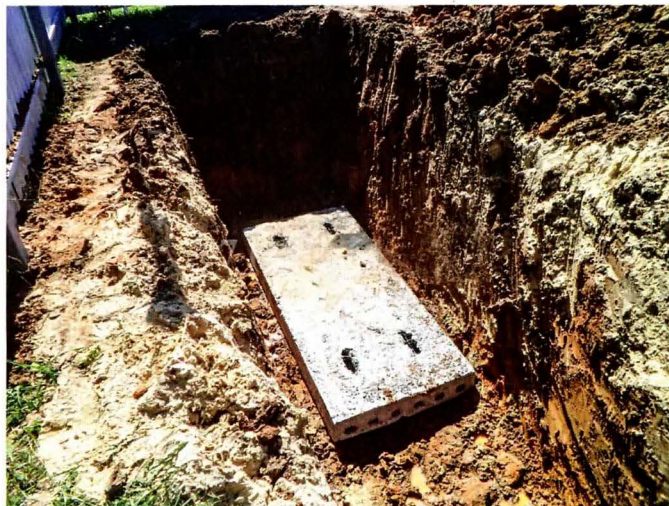
На дно котлована укладывают бетонную плиту, на которой монтируют резервуар.
