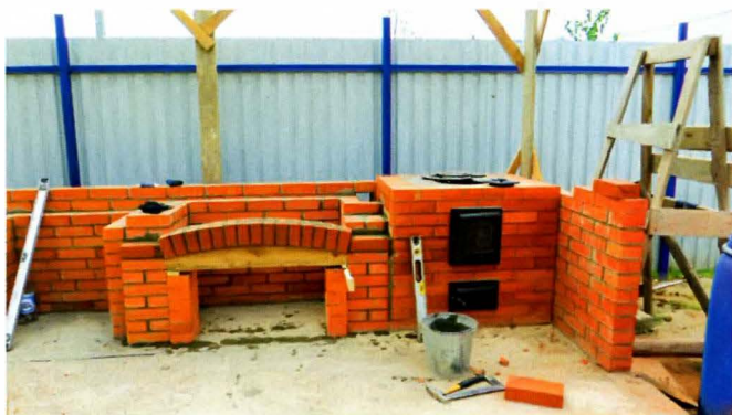
Сначала мастер выложил нижнюю часть мангала — нишу для дров. Основную часть ниши перекрыл на стальных уголках 50 × 50 мм, а её портал — арочным сводом.
