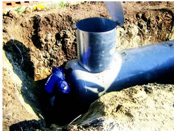
Глубину заложения резервуара выбирают исходя из условий устойчивой работы газгольдера в морозы.
