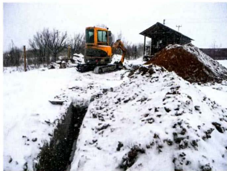
Мини-экскаватор быстро и аккуратно прокопал траншею и вырыл котлован под резервуар.
