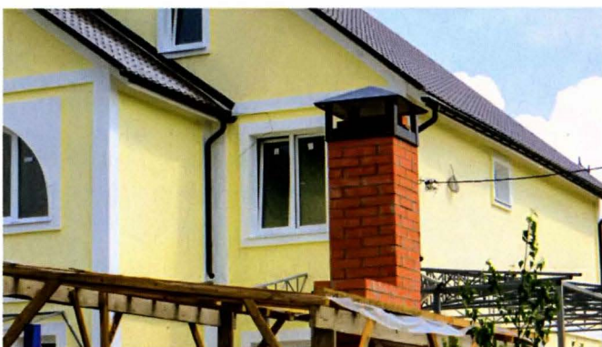
... а затем выложена труба высотой 1,5 м.
