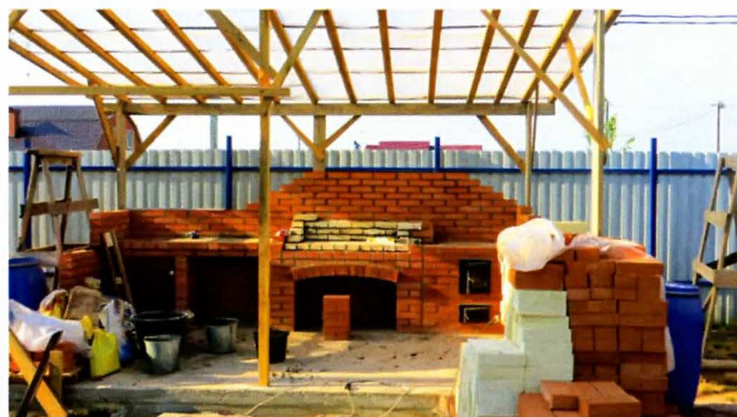
Второй ряд перекрытия ниши сделан из огнеупорного шамотного кирпича — этот ряд должен стать подом будущего мангала.
