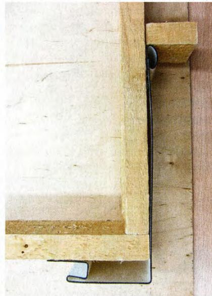
↑ Обрамление окна приоконным профилем с финишной планкой.
