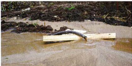
Когда вы достигнете водоносного слоя, предстоит самое сложное — работать, стоя в ледяной мутной жиже. Но с монитором характер работы резко изменяется: насос довольно легко поднимает на поверхность насыщенную песком пульпу.
