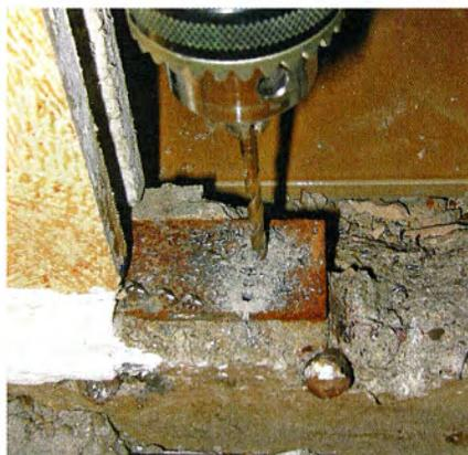
↑ Срезать металлическую закладную деталь можно было болгаркой, но уж больно много цементной пыли и грязи при этом образуется. Если ремонт — локальный (только в ванной), лучше пожертвовать временем.
