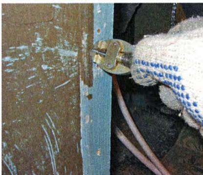
↑ Лишние шурупы со стёртым шлицом можно вывинтить с помощью ручных тисочков.
