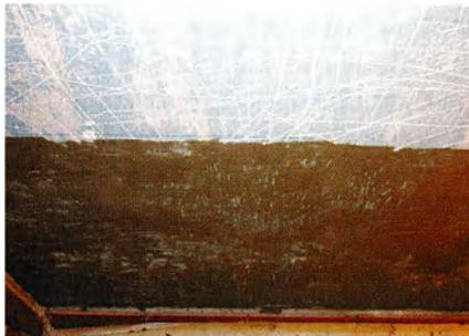
↑ Перед облицовкой плиткой я прошпатлевал стены из шифера плиточным клеем и хорошо просушил.
