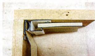
↑ Сочленение стены и карниза с софитами одним J-профилем и финишной планкой с неполной панелью.
