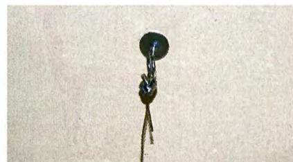
↑ Как просто работать с гарпунчиком! Просверлил отверстие в гипсокартоне, вставил гарпунчик, закрутил гайку — и крючок надёжно закреплён.
