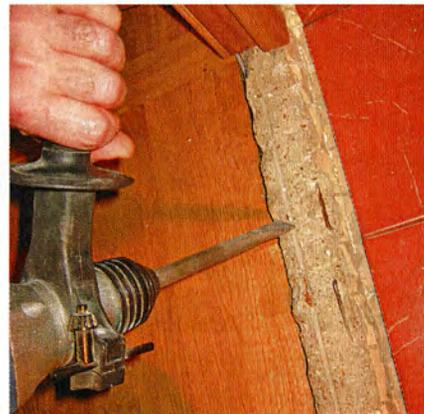
↑ Мне пришлось немного подрубить бетон на входе в ванную, чтобы между порогом, облицованным плиткой, и низом двери оставался зазор для вентиляции помещения. Такую работу с использованием ударного инструмента надо делать до приклеивания плитки на тонкие стены санкабины.
