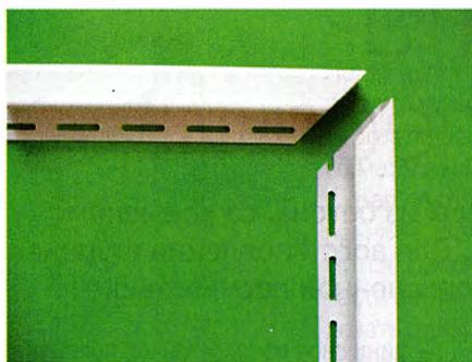
↑ Соединение J-профилей с обрезкой концов под углом 45 градусов. Часто получается щель.
