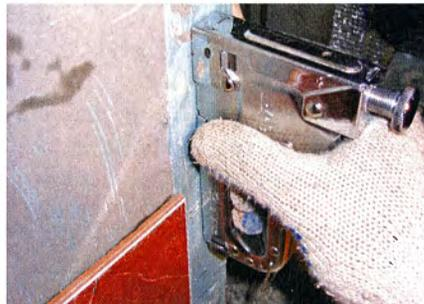
↑ Деревянные конструкции, где надо было приклеивать плитку, «армировал» скобами с помощью степлера.
