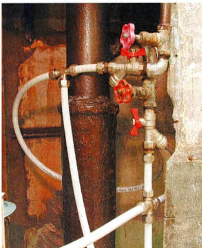
↑ Новый водопровод в квартире я собрал заранее из металлопластиковых труб. Подключение его заняло около часа.
