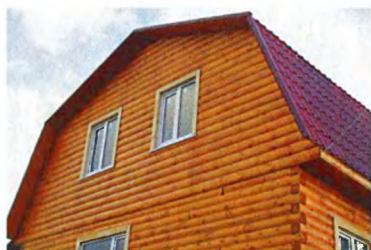
Фронтон дома обшит блок-хаусом, а стены собраны из профилированного бруса.
