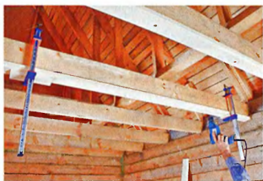
Сначала крепят накладки.
