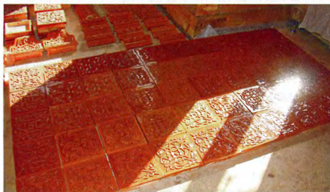
Выкладка изразцового экрана, выходящего в коридор.
