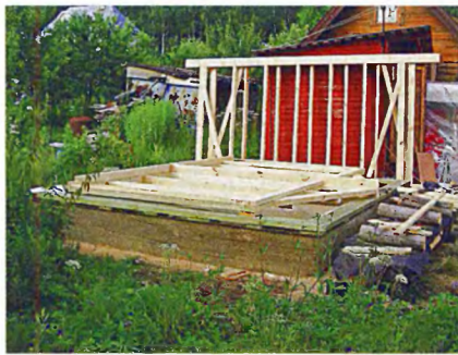
Нижнюю обвязку я установил на подкладках.
