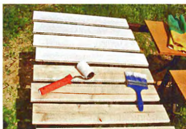
Вагонку, предварительно напиленную в размер, окрашивают.
