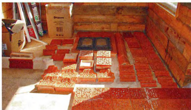
Выкладка изразцовой облицовки главного фасада.
