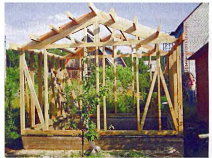
Жёстко зафиксировать балки крыши помогают вставки между ними.
