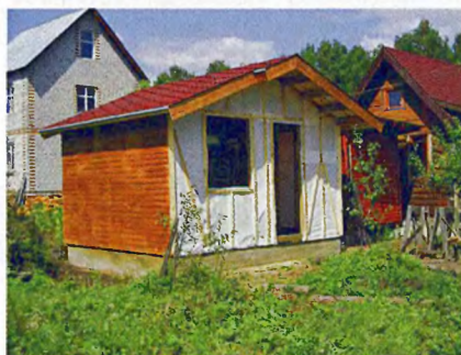
Прежде чем обшивать фронтонную стену, сформировал оконный и дверной проёмы.
