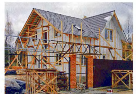
Наружное утепление пенополистиролом стен загородного дома.
