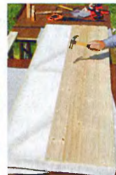
Отделка двери изнутри.
