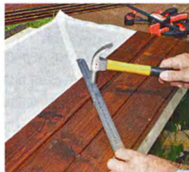
Гвозди прибавают строго по линии.
