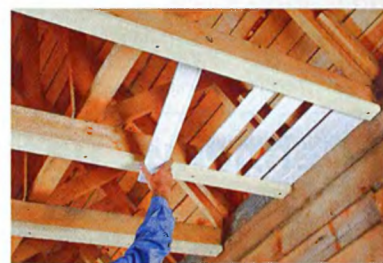
Заготовки укладывают по месту.
