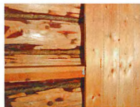
Использование кляммеров на открытых взгляду поверхностях.
