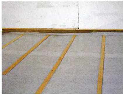
Утеплённый пол закрыл пароизоляционной плёнкой.
