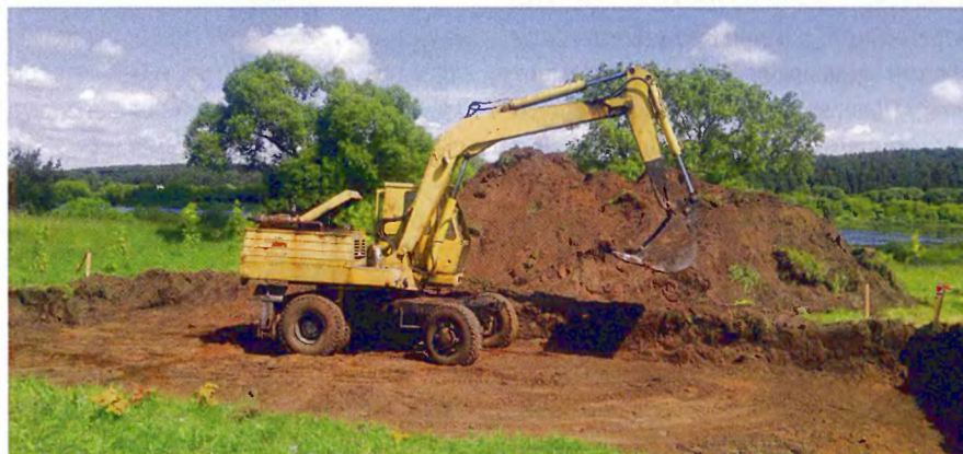
На площадке, где будет фундамент дома, снимают растительный слой грунта.
