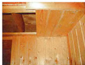
Плинтус потом закроет шляпки гвоздей.
