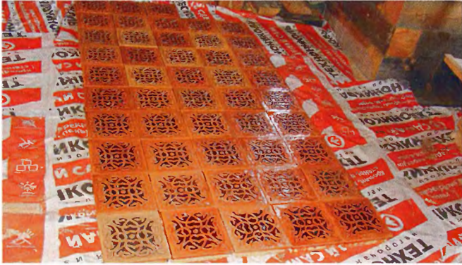
Выкладка изразцового экрана для кухни. Декорирован росписью.
