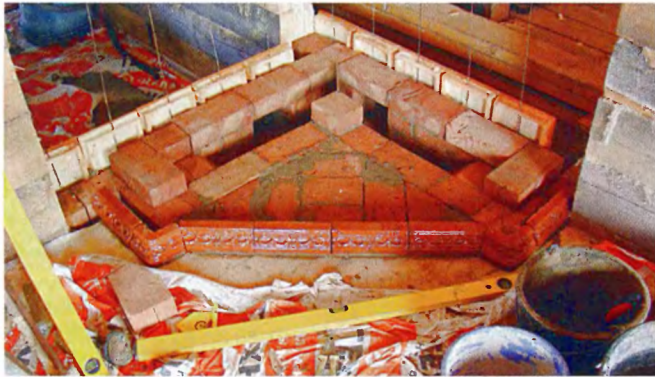
Первые ряды кладки. Сначала выставляю изразцы, потом кладу кирпич. Далее идёт заполнение пустот между изразцами и кирпичом. Связывание двух слоёв (кирпичей и изразцов) делает изделие прочным единым организмом.
