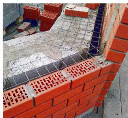
Облицовка газоблока кирпичом с вентилязором.
