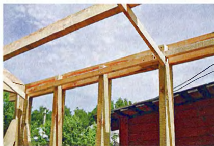
Верхняя обвязка — пятидесятка, установленная на ребро.
