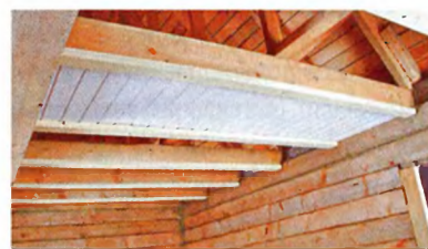
Одна секция потолка готова.
