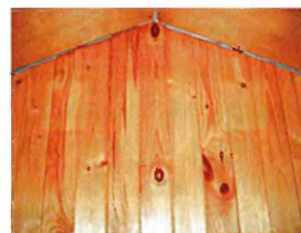
Это вагонка штиль, прибитая гвоздями под наклоном 45°.
