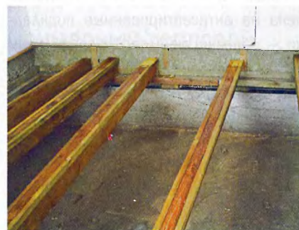
Половые лаги с набитыми черепными брусками сохнут после обработки антисептиком.
