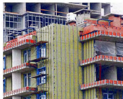
Наружное утепление стен многоквартирного дома.
