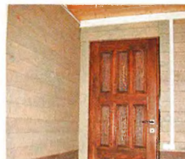
Отделка поверхности маслом в разные цвета. Здесь использовалась вагонка.
