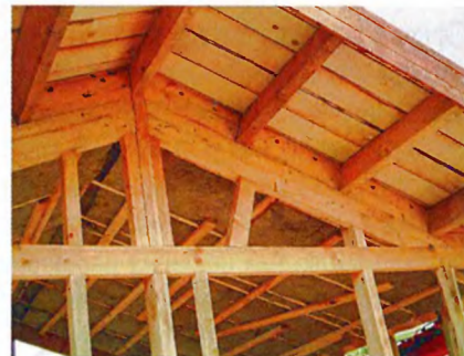
Для вентиляции подкровельного пространства в досках-распорках насверлил ряд отверстий.
