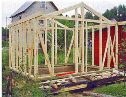
Установлены каркасы всех четырёх стен.
