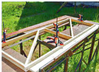
Изготовление каркаса двери. Диагональные раскосы обязательны.
