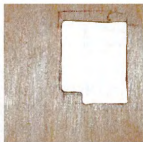
Паз в задней стенке для навеса — элемента крепления полки к шине.
