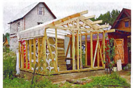
Поверх каркаса крыши настелен полиэтилен. Под такой временной крышей можно укрыть утеплитель от дождя.
