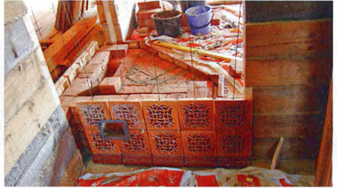
Монтаж экрана, выходящего на кухню.
