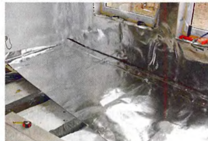
Внутреннее утепление стен дома и пароизоляция способствуют повышению уровня влажности в помещении.
