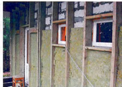
Наружное утепление стен дома из мелких блоков ячеистого бетона.
