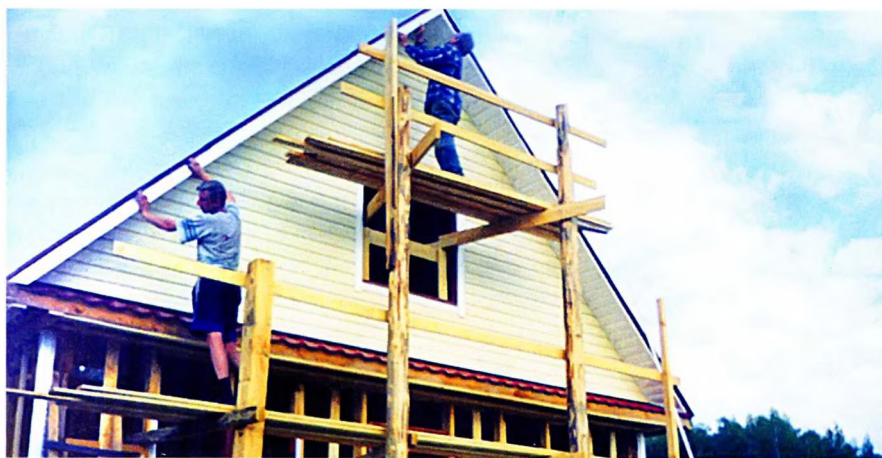
Установка лобовых досок на свесы обрешётки. С лесов работать удобно.
