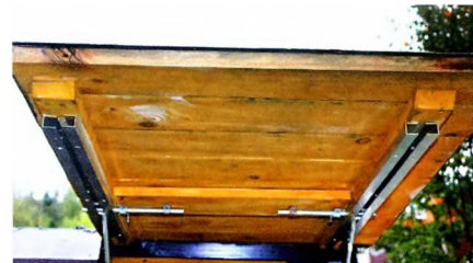
В качестве полозков для стоек использованы пары П-образных алюминиевых профилей.
