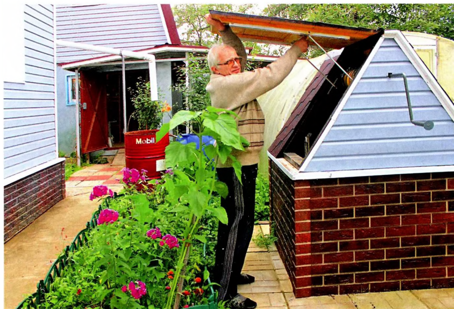
В качестве полозков для стоек использованы пары П-образных алюминиевых профилей.
