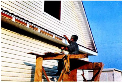
Установка лобовых карнизных панелей. Для их крепления использованы импровизированные держатели, вырезанные из отходов виниловых наличников.
