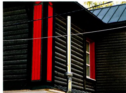
Наружная часть вентиляционной системы для удаления радона из подвала дома.
