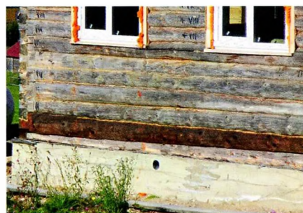
Недостаточные по размеру или закрытые «для тепла» вентиляционные продухи в подполье — причина повышения концентрации радона в доме.
