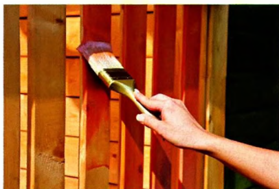
Красящий состав необходимо наносить вдоль волокон дерева.
