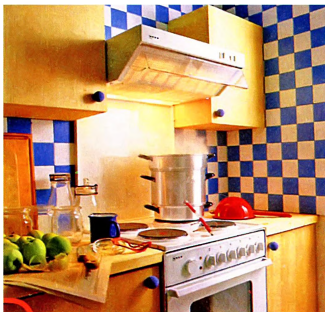
Вытяжка-воздухоочиститель, работающая в режиме отвода или циркуляции воздуха. Монтируется на стене между двумя настенными шкафами. Вытяжка обычно имеет заборную решётку, аэрозольный и угольный фильтры, а снизу — встроенный светильник.
