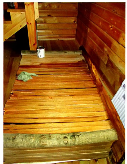
Дубовые элементы покрыли тиковым маслом.
