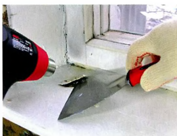
Быстро удалить старую краску с бетонного подоконника можно при помощи строительного фена.
