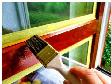
При покраске оконных рам край стекла защитите малярным скотчем. После выполнения работы не держите долго скотч на стекле.
