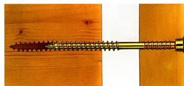
Вращая шуруп влево, установите необходимый зазор между ограждающей конструкцией и прикрепляемым предметом.
