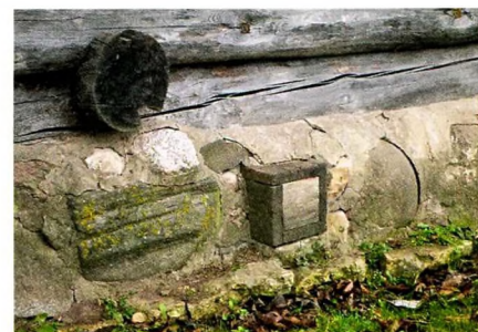
Недостаточные по размеру или закрытые «для тепла» вентиляционные продухи в подполье — причина повышения концентрации радона в доме.
