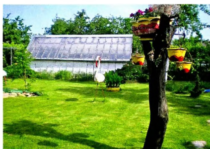
Общий вид теплицы с покрытием из поликарбоната.
