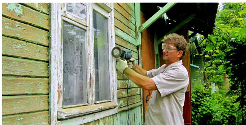
Более тонкую работу делаем с помощью электродрели.
