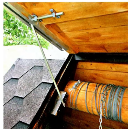
Нижний конец стойки шарнирно соединён с боковиной проёма.
