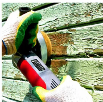
Старое красочное покрытие с деревянной стены хозблока можно снять болгаркой с металлической щёткой.
