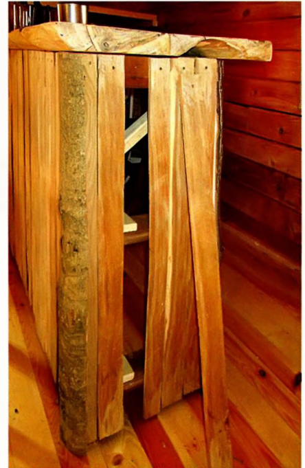
Плашки фасадов крепили к каркасу саморезами.
