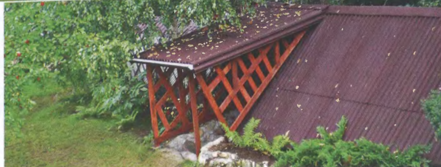
Комплекс после обустройства оврага.
