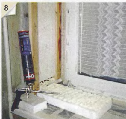
8 Пустоты в обрешётке заполняем монтажной пеной и пенопластом.
