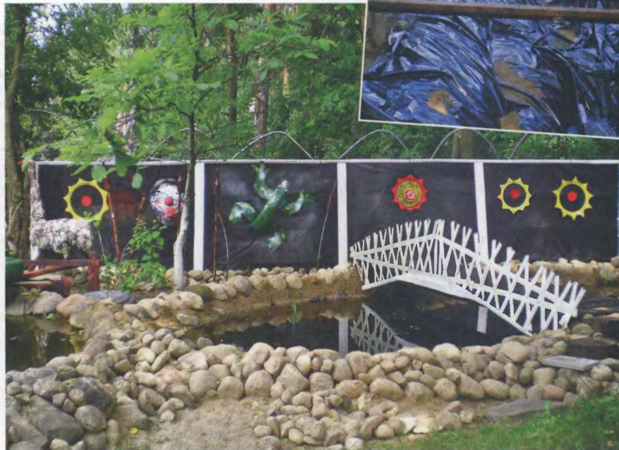
Обустроенный водоём. Рабочий момент укладки изоляционной плёнки при формировании водоёма.
