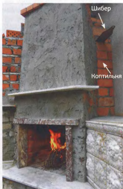
Для регулировки потока дыма в параллельном канале устроили шибер — после коптильни перед входом в зауженное место основного дымохода.
