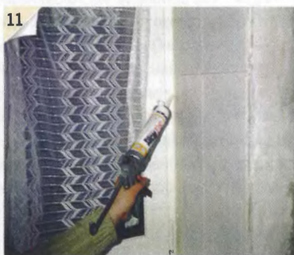
11 Зазоры между плиткой и пластиковым окном заполняем силиконовым герметиком...
