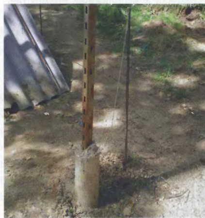
Устройство столбчатых (свайных) фундаментов под навес и другие конструкции на насыпных грунтах.
