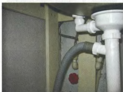
Стойки внутри угловой «тумбы».
