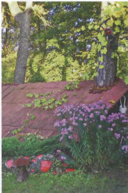
Сохранённые деревья стали опорой для каркаса сарая-склада.
