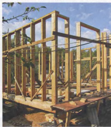
Это только часть стоек каркаса, но все отрезаны торцовкой.
