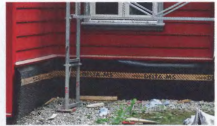
Пристеночная дренажно-гидроизоляционная мембрана. Реконструкция дома в г. Флом, Норвегия.
