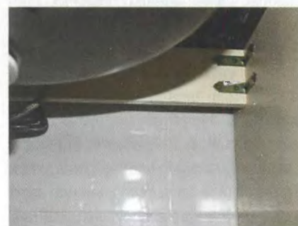
Соединение тумб, примыкающих к углу, горизонтальными планками с помощью уголков.
