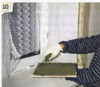
10 Обшитые гипсокартоном откосы облицовываем керамической плиткой.
