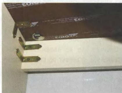
Соединение тумб, примыкающих к углу, горизонтальными планками с помощью уголков.
