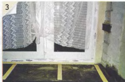
3 Опорой для подоконника служат фанерные планки толщиной 9–10 мм, прикреплённые к стяжке.
