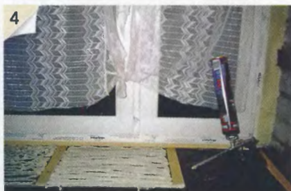
4 В пространство между планками наносим монтажную пену тонким слоем.
