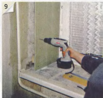
9 К обрешётке крепим панели, выкроенные из гипсокартонных листов.
