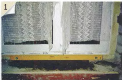
1 Маяки из цементного раствора выровнены по столбикам, склеенным из обрезков керамической плитки.
