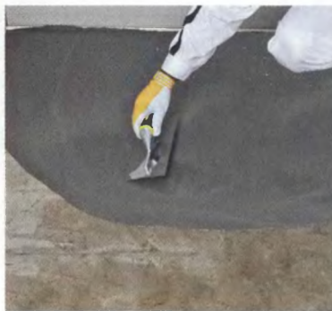
Основание из бетона также требует выравнивания.
