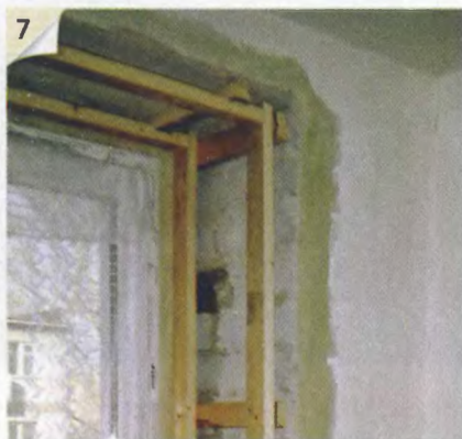
7 Несущей конструкцией для обшивки откосов служит обрешётка из брусков.
