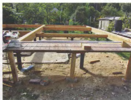
Треугольный деревянный упор справа работает ограничителем, позволяющим точно задать длину стойки.
