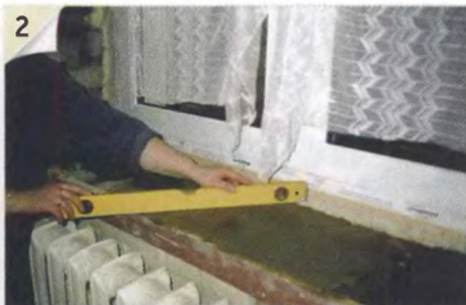
2 Стяжка, залитая по двум протяжённым маякам, получается ровной.
