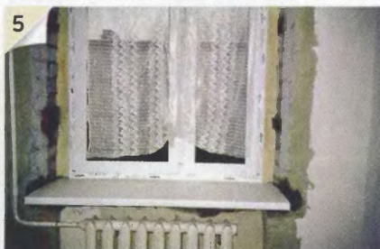
5 Подоконник приклеиваем на монтажную пену и до её высыхания прижимаем грузами.
