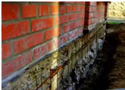
Готовый арматурный каркас.
