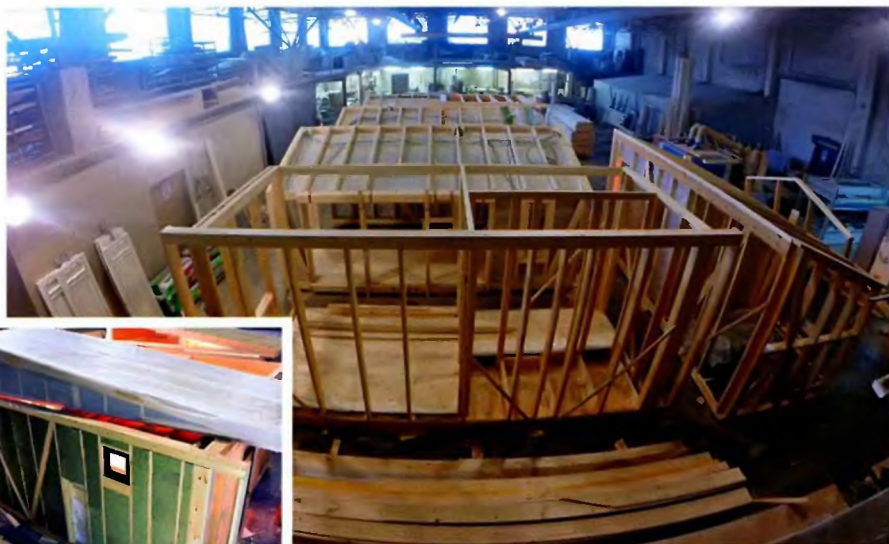
Сборка модулей в цехе.
