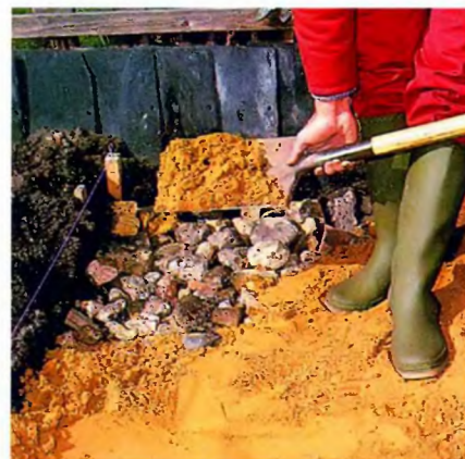
На выровненное дно котлована отсыпают сначала гравий, а затем — песок. И тот, и другой тщательно утрамбовывают.
