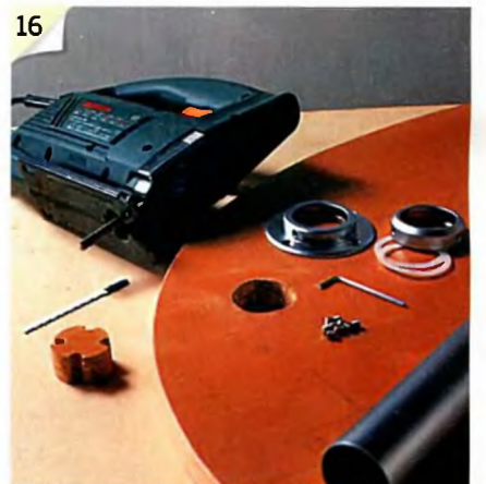
16 Стол соединяют с кухонным блоком многофункциональной стойкой, пропущенной через отверстия Ø 45 мм. Края и стенки просверленных отверстий до этого зачищают круглым напильником.
