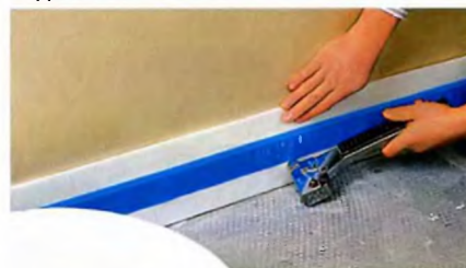
Между краями звукоизоляционных плит и стеной оставляют зазор, который заполняют полосами звукоизоляционного материала.
