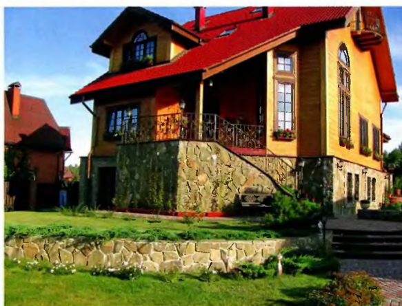
Подпорная стенка как элемент террасирования выполнена в одном стиле с высоким цоколем дома.
