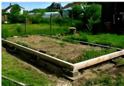
Обвязка теплицы приподнята на 15 см над грунтом и установлена на самодельных бетонных столбиках.
