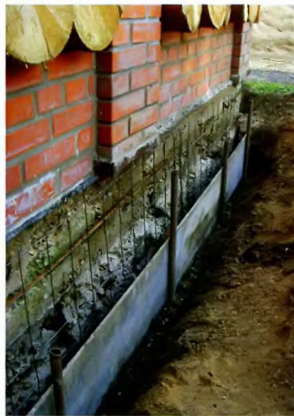
С этой стороны крепление опалубки сделано в виде опор из металлических уголков, вбитых глубоко в землю.
