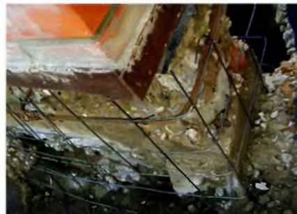
Армопояс и сетка «обнимают» весь фундамент по периметру, образуя замкнутый контур.
