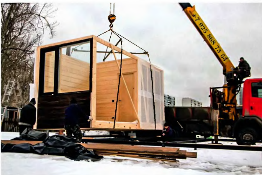
Установка модуля на винтовой фундамент.
