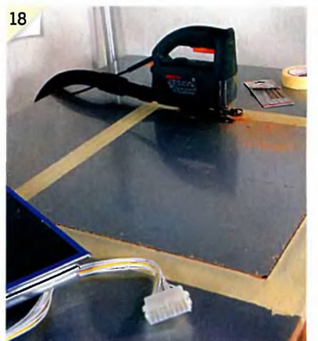
18 Прём под варочную панель вырезают электролобзиком. Чтобы избежать царапин на облицовке из нержавеющей стали, края будущего проёма оклеивают малярной лентой.
