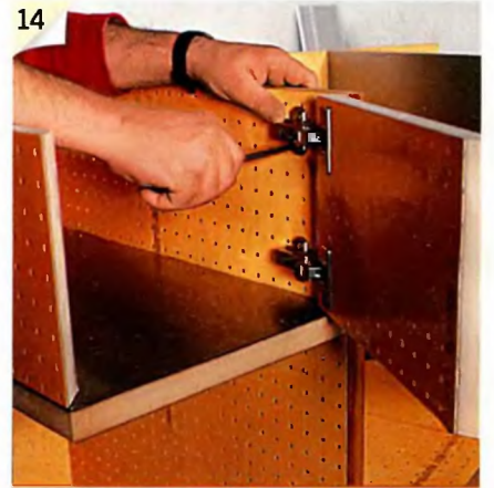
14 Прикрепив основание петли двумя шурупами, дверку выставляют установочными винтами.
