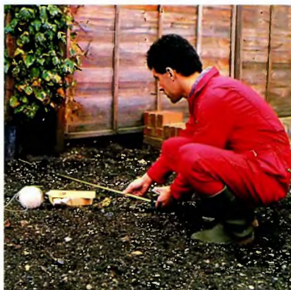
Определение размеров и обозначение границ участка, отведённого под площадку, при помощи колышков и натянутого шнура.
