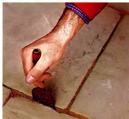
Песок при заполнении им швов обильно проливают водой или слегка утрамбовывают широким зубилом.
