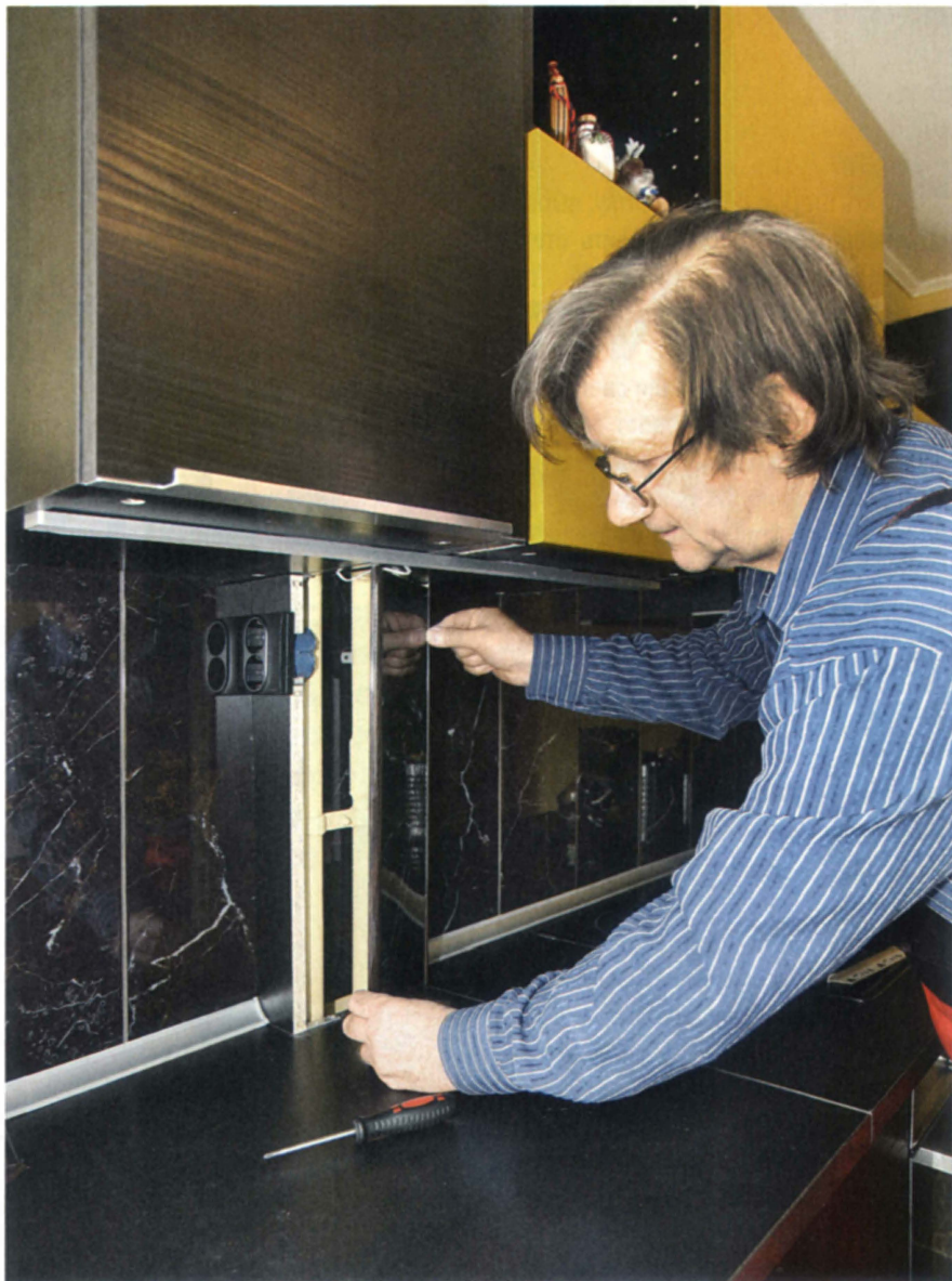
Внутри короба в пластиковом кабельном канале проложил электрические провода освещения для светодиодных светильников в верхней части кухни, а сбоку расположил электрическую розетку для кухонной техники.
