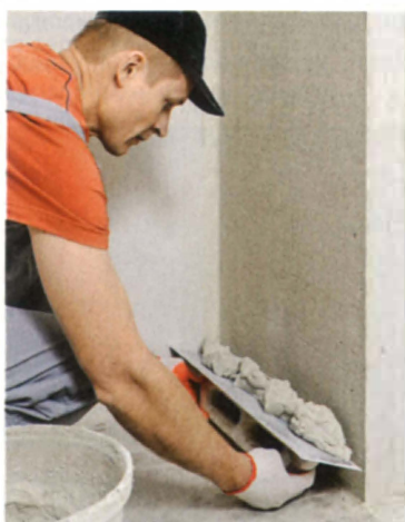
Можно наносить раствор на гладилку и сразу выравнивать его на стене. Распределяйте раствор снизу вверх.
