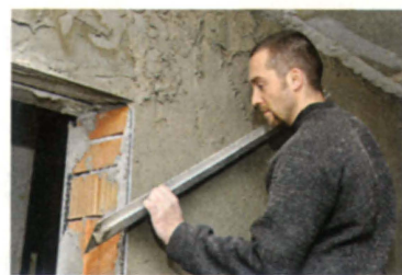
При штукатурке откосов у дверных проёмов и окон наносите раствор с нахлёстом.
