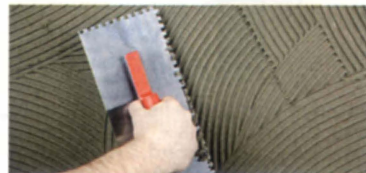
Когда надо уложить толстый слой покрытия, это делают в несколько этапов. Обязательно надо дать просохнуть одному слою и нанести на него насечки для лучшей адгезии с последующим слоем. Можно использовать зубчатый шпатель.
