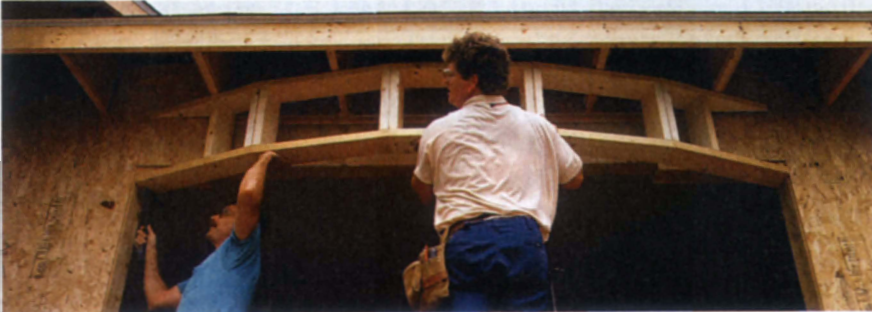
Свес крыши довольно широк, поэтому над окном соорудили стенку. Каркас её составлен из пяти отдельных рамок, собранных по контуру окна. Рамки соединены вместе, собранный каркас прибит к стропилам и перемычке, перекрывающей проём окна.
