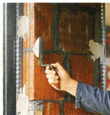
Маяки крепят к стене на лепёшках гипсового раствора. Выравнивают их по вертикали и друг с другом (выставляют в одну плоскость).
