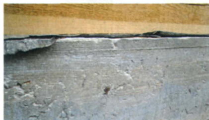
Между нижней обвязкой деревянного дома и фундаментом обязательно должна быть проложена гидроизоляция, например один-два слоя рубероида или гидроизола.
