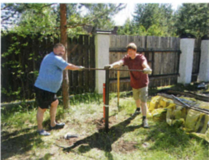
Винтовые сваи нельзя дважды вкручивать в одно и то же место: грунт в этом случае будет разрыхлён, что может привести к осадке свай под нагрузкой от здания.
