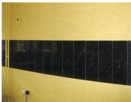
Трубы отопления предстояло спрятать.
