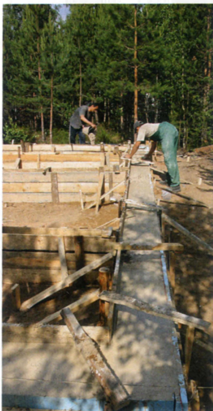
Высота опалубки должна быть на 5–7 см выше проектного уровня поверхности фундамента.
