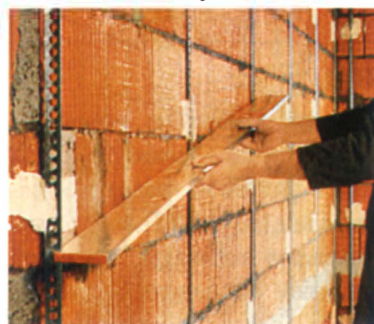
Вдавите маяк в смесь с помощью правила. Расстояние между маяками должно быть меньше половины длины правила.
