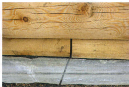
Подкладная доска ниже теплового контура дома, поэтому зазоры в стыковках по длине возможны, но нежелательны. Проблема решается спилом стыков под углом 45 градусов.
