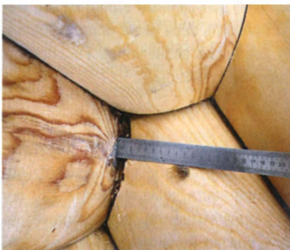
Выборка бревна в угловых стыках должна быть ровной, без сколов. Недопустимы показанные на фото зазоры свыше 1 мм помимо толщины самого утеплителя.
