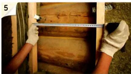
5 Там, где расстояние между брусками меньше 600 мм, плиты утеплителя подрезают по ширине.
