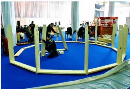
Процесс сборки каркаса технологичен — смонтировать первый ярус два человека могут за несколько минут.
