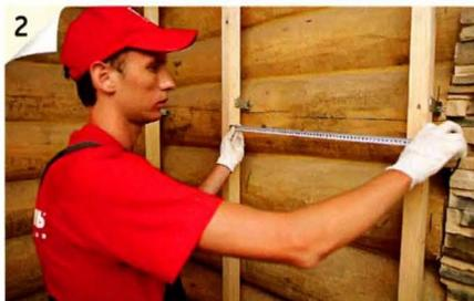
2 Расстояние между брусками обрешётки должно быть таким, чтобы плиты утеплителя плотно вставали враспор.
