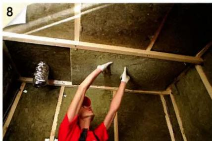
8 На потолке необходим двойной слой теплоизоляции. Бруски обрешётки набивают с таким же шагом, как и на стенах.
