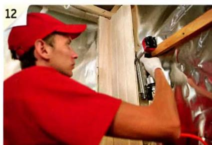
12 Вагонку крепят финишными гвоздями, забивая их в паз досок, чтобы снаружи не оставалось металлических шляпок крепежа.
