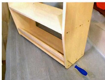
Чтобы планка не крутилась вокруг шканта, дополнительно закрепим её саморезами. У боковых секций эта планка с одной из сторон имеет по два шканта — и она не крутится.
