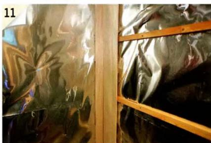
11 Поверх фольги к обрешётке прибивают бруски, предназначенные для монтажа вагонки.
