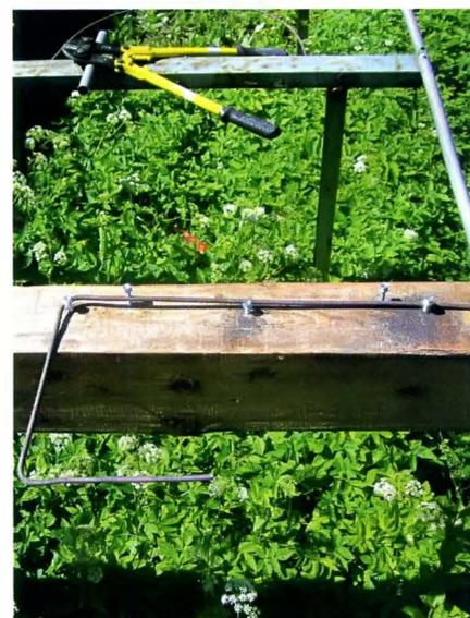
Крайние саморезы задают длинную сторону хомута. Проволоку  $\varnothing$  6 мм легко резать небольшими болторезными ножницами.
