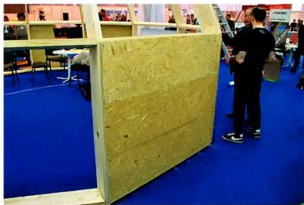
Обшивка ориентированно-стружечными плитами первого яруса купола. Плита для одной секции может быть и составной.
