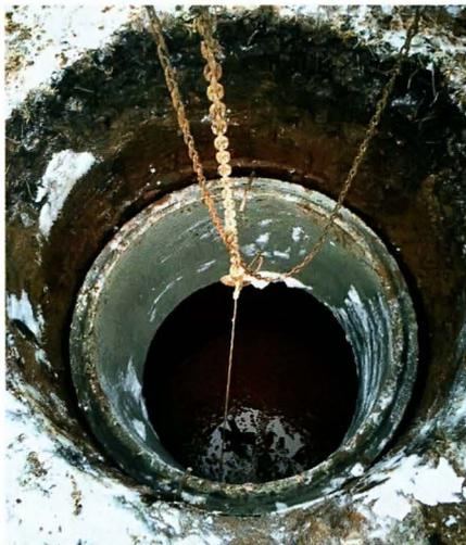
Кольцо зацепляли с помощью тросика и двух прутьев арматуры. В технологические отверстия с двух противоположных сторон бетонного кольца просовывали петлю троса и снаружи кольца вставляли в неё прут.
