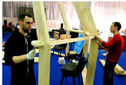
Поперечную распорку сверху надевают на нагели. Заготовка точно встанет на место — размеры всех деталей точно рассчитаны.
