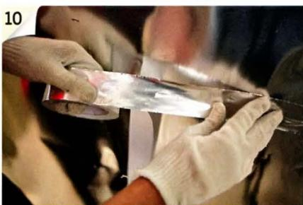
10 Стык полотен фольги обязательно проклеивают алюминиевым скотчем. Случайный разрыв фольги обязательно заклеивают.
