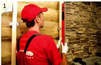
1 Обрешётку из брусков сечением 50 × 50 мм монтируют на стенах строго вертикально и в одной плоскости.
