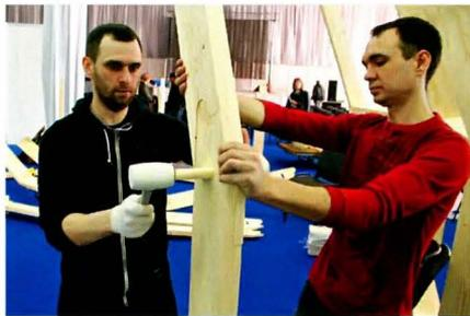
Стойки первого и второго яруса, соединённые в замок, фиксируют нагелем, проходящим через обе стойки.
