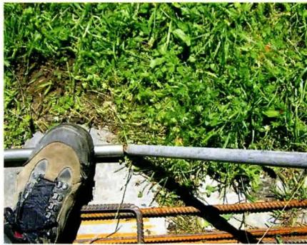
Две стальные трубы, надетые на прут, позволяют аккуратно и без особых усилий согнуть прут диаметром до 14 мм...
