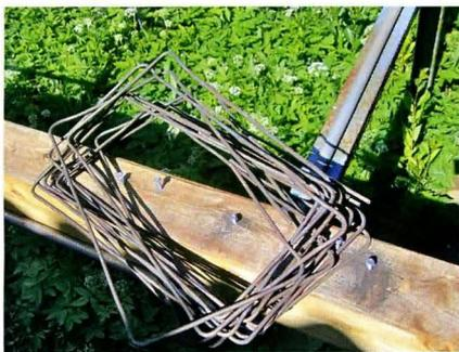
Нехитрое приспособление позволяет значительно сэкономить время и изготовить хомуты одинакового размера и в нужном количестве.
