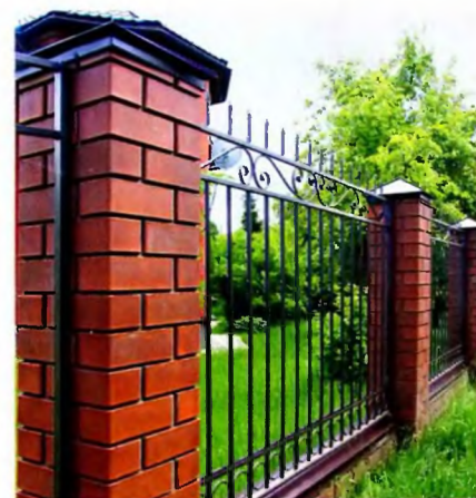
Комбинированный забор из кирпича и решётки из металла на монолитном основании.
