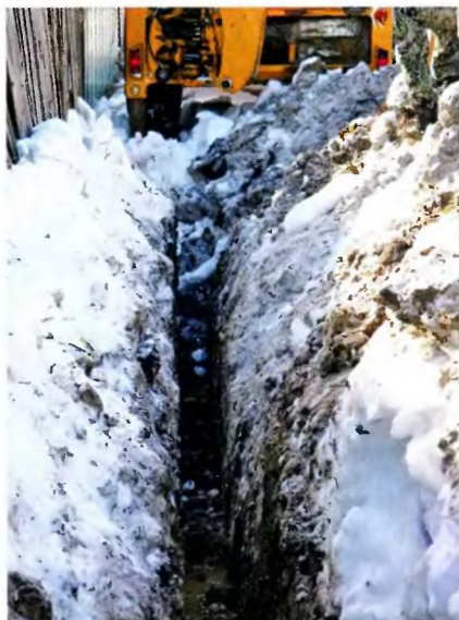
Для экономии щебня и песка ковш для работ выбрали шириной 30 см, глубина траншеи — 1,2 м.
