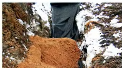
Размотав 3–4 м геотекстиля, высыпали ковш песка, затем снова разворачивали полотно и т.д.
