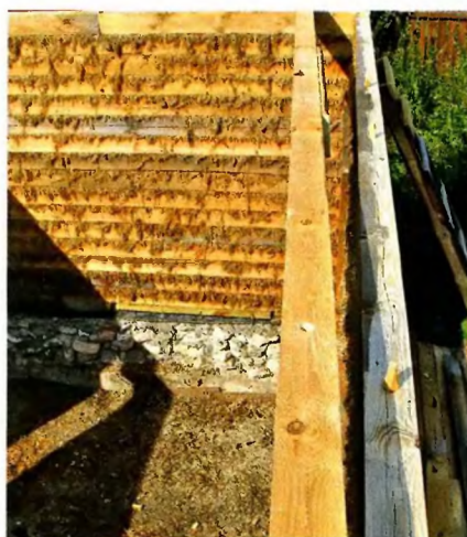
Сверлили отверстия и ставили нагели.
