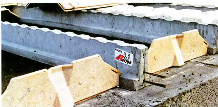
Опорная часть перекрытия, торцевые заглушки при устройстве сборно-монолитной плиты.
