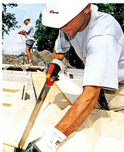
Резать заготовки можно ручной ножовкой или сабельной пилой.
