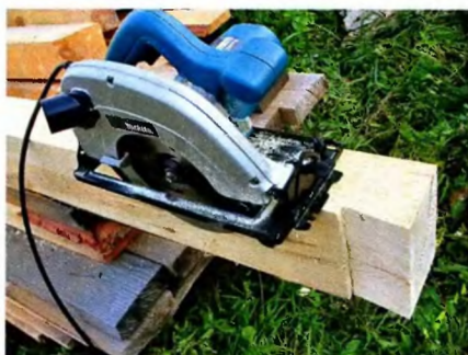
Балку врезали в стену, используя врубку «ласточкин хвост».
