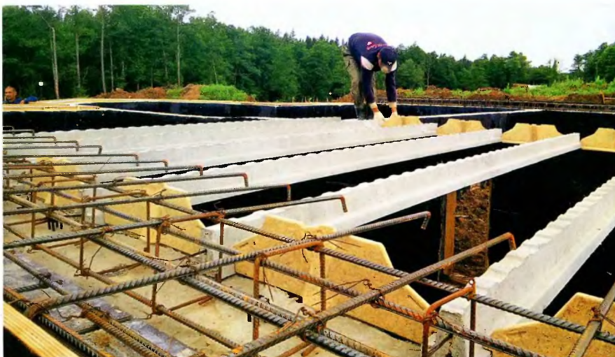
Опорная часть перекрытия, торцевые заглушки при устройстве сборно-монолитной плиты.
