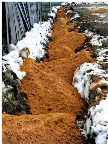
Вторым слоем уже под завязку засыпали «дренажку» песком до уровня земли.
