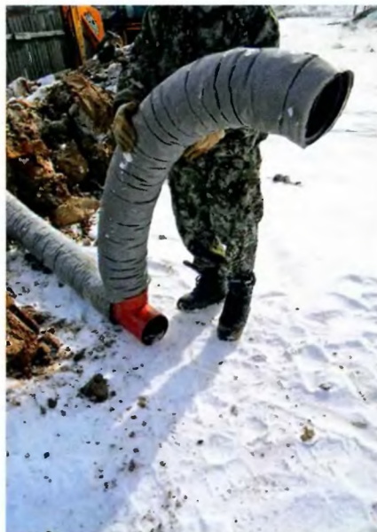
Надрезав край трубы, надевали её на тройник, а чтобы она не слетала, стягивали край проволокой.
