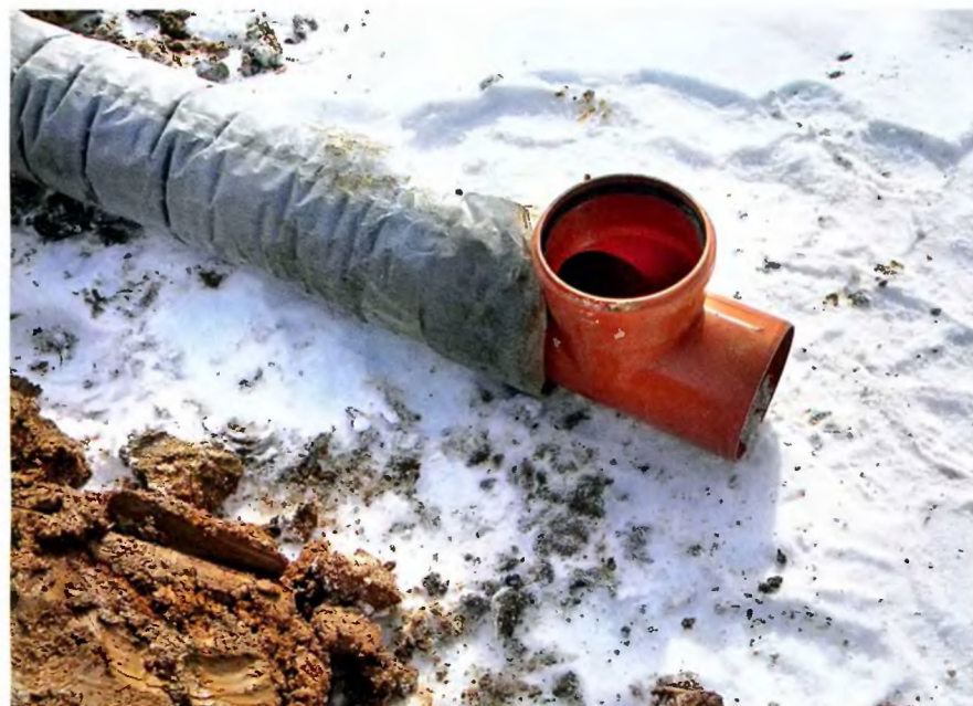
Тройники устанавливали через каждые 40 м — в конце каждой бухты.
