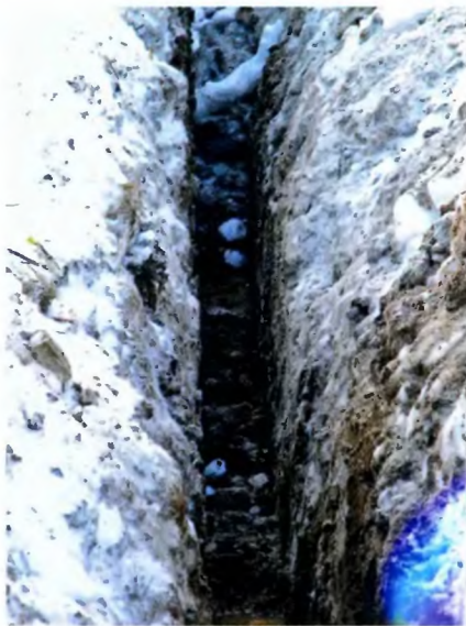
Узкая траншея стала осыпаться, поэтому её пришлось расширять.
