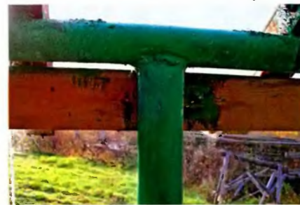
Крепление деревянных элементов крыши и стен к железному каркасу.
