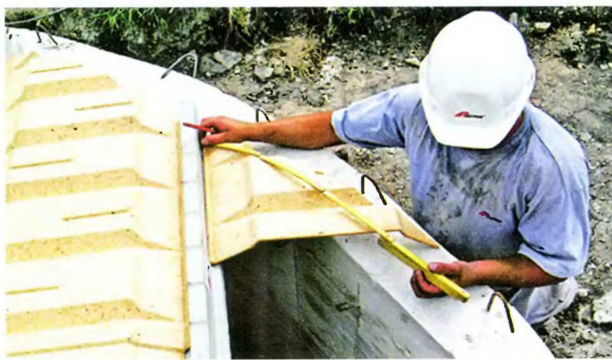
Подрезать можно в любом направлении и опирать на балки как целой, так и подрезанной стороной.
