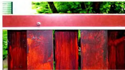
Металлический козырёк защищает торцы досок от осадков.
