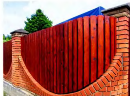
Комбинированный забор из кирпича и дерева на монолитном основании.
