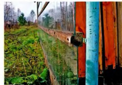
Остекление продольной стены теплицы.
