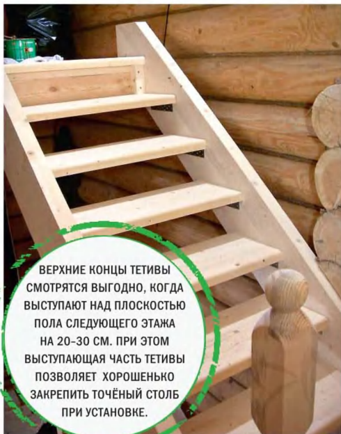
Рис. 4 ПРИ МОНТАЖЕ ОГРАЖДЕНИЙ НЕОБХОДИМО ПРЯТАТЬ ЭЛЕМЕНТЫ КРЕПЛЕНИЯ.
