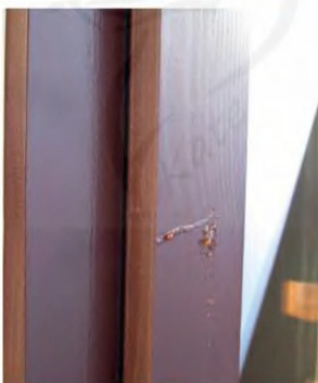
Смола локально выступила на красивых деревянных окнах. Под слоем краски скрываются смоляные кармашки.
