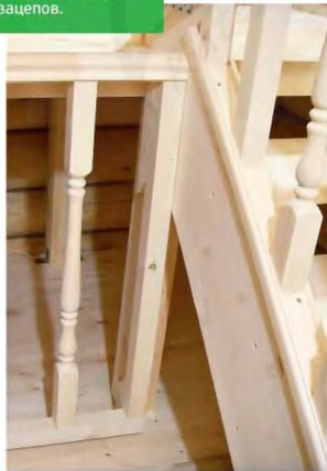
Своеобразный декоративный экран легко установить на место с помощью деревянных зацепов.
