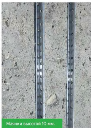
Маячки высотой 10 мм.
