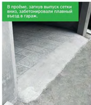
Для заделки швов между плитками использовали мелкодисперсную смесь М300, которой засыпали зазоры и также пролили водой.
