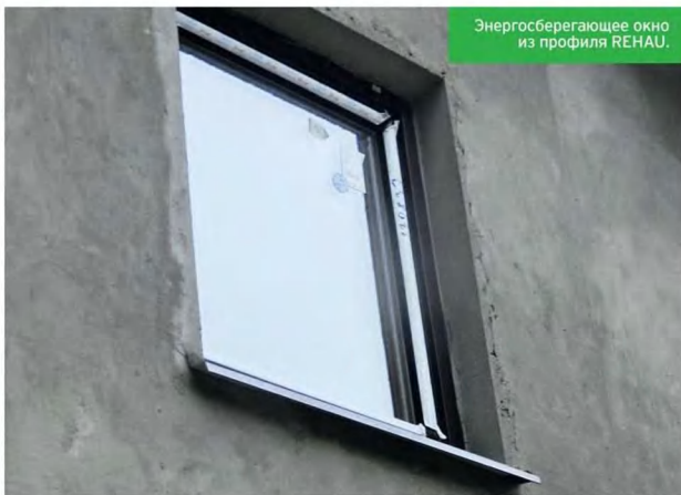
Между внутренней и внешней рамками — слой штукатурки.
