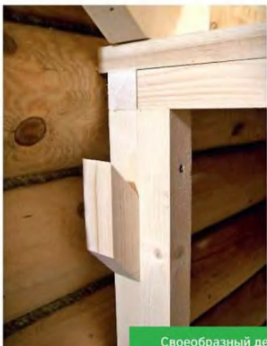
Своеобразный декоративный экран легко установить на место с помощью деревянных зацепов.
