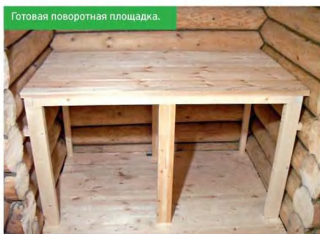
Каркас поворотной площадки.
