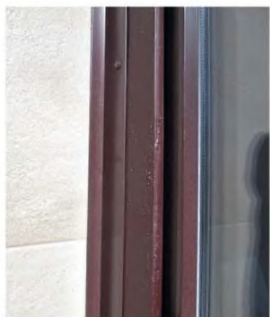
Смола локально выступила на красивых деревянных окнах. Под слоем краски скрываются смоляные кармашки.
