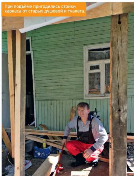
Поднять крышу в одиночку без вспомогательного оборудования оказалась не под силу. Понадобился автомобильный домкрат.
