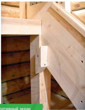
Своеобразный декоративный экран легко установить на место с помощью деревянных зацепов.
