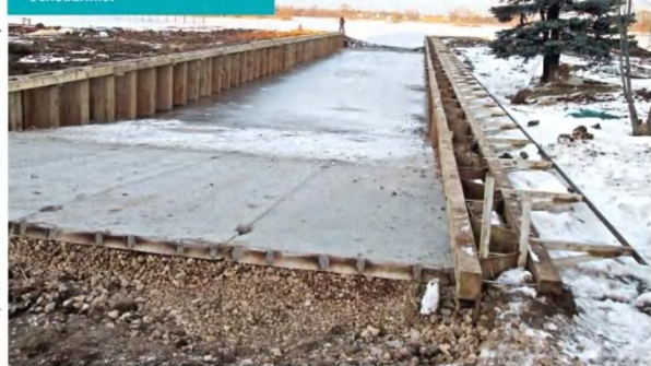
Слип выложили из азбестовых бетонных плит по песчано-щебёнчному основанию.
