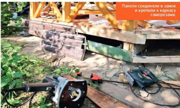
Каркас для крепления цокольных панелей собрали из брусков, которые крепили саморезами с помощью перфорированных металлических пластин.
