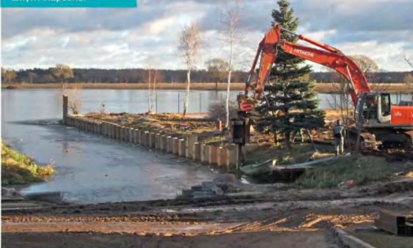
Для укрепления берегов использовали стальной шпунт Ларсена.
