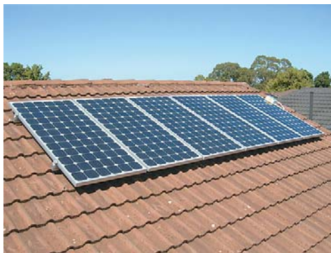
Рис. 51. Солнечная батарея, изготовленная с применением кристаллического кремния
