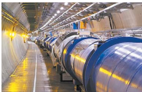
Рис. 135. Участок кольца коллайдера в тоннеле
