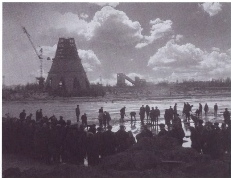
Строительство Останкинской телебашни. 1964 г.
