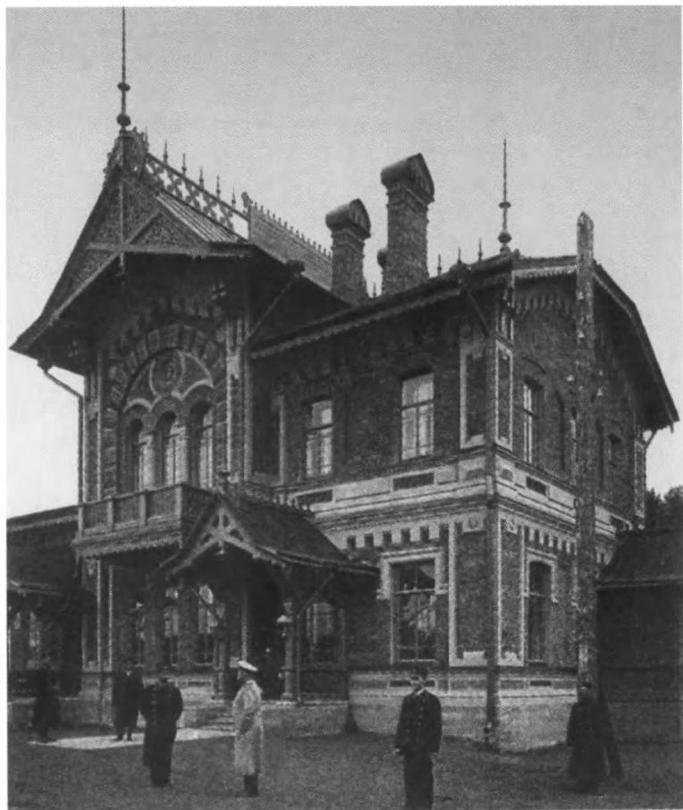
Станция Можайская Балтийской железной дороги. Фотография 1899 г.
