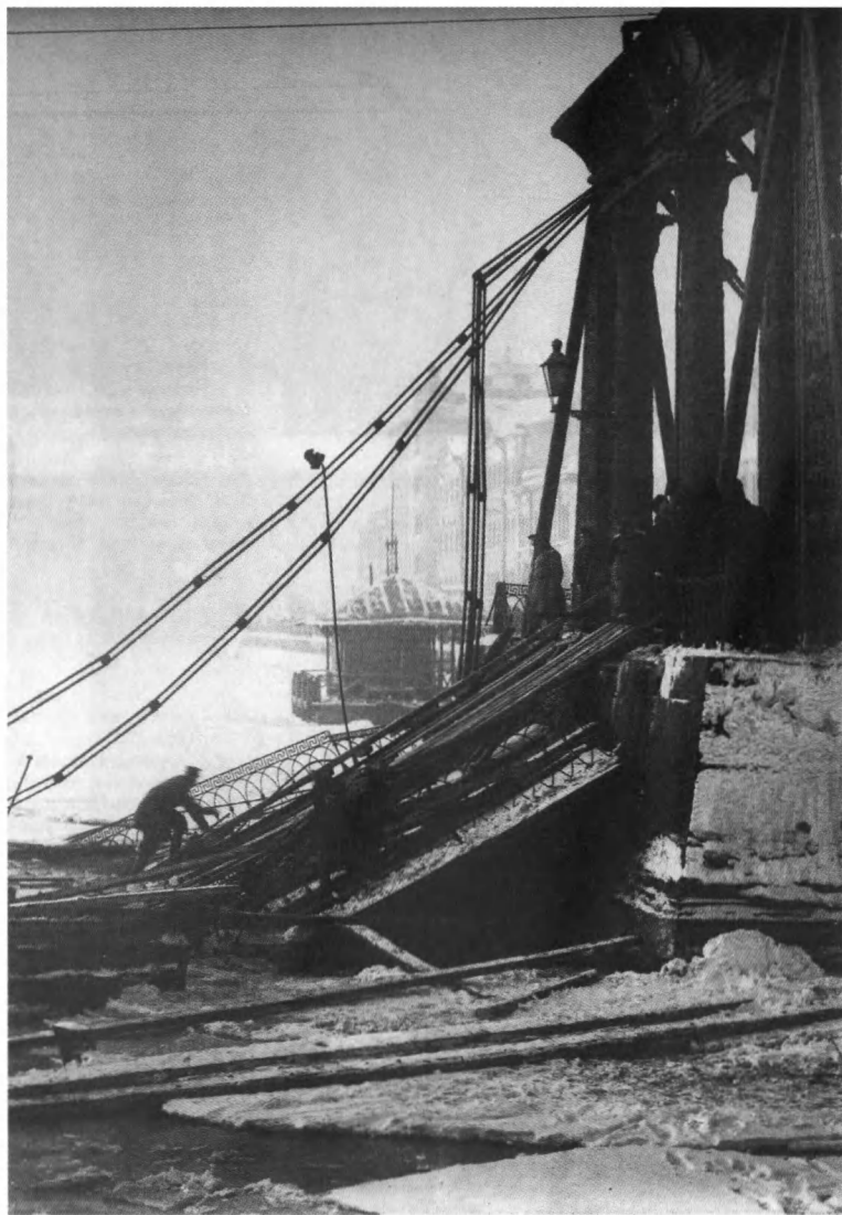
Разборка рухнувшего Египетского моста. Фотография 20 января 1905 г.
