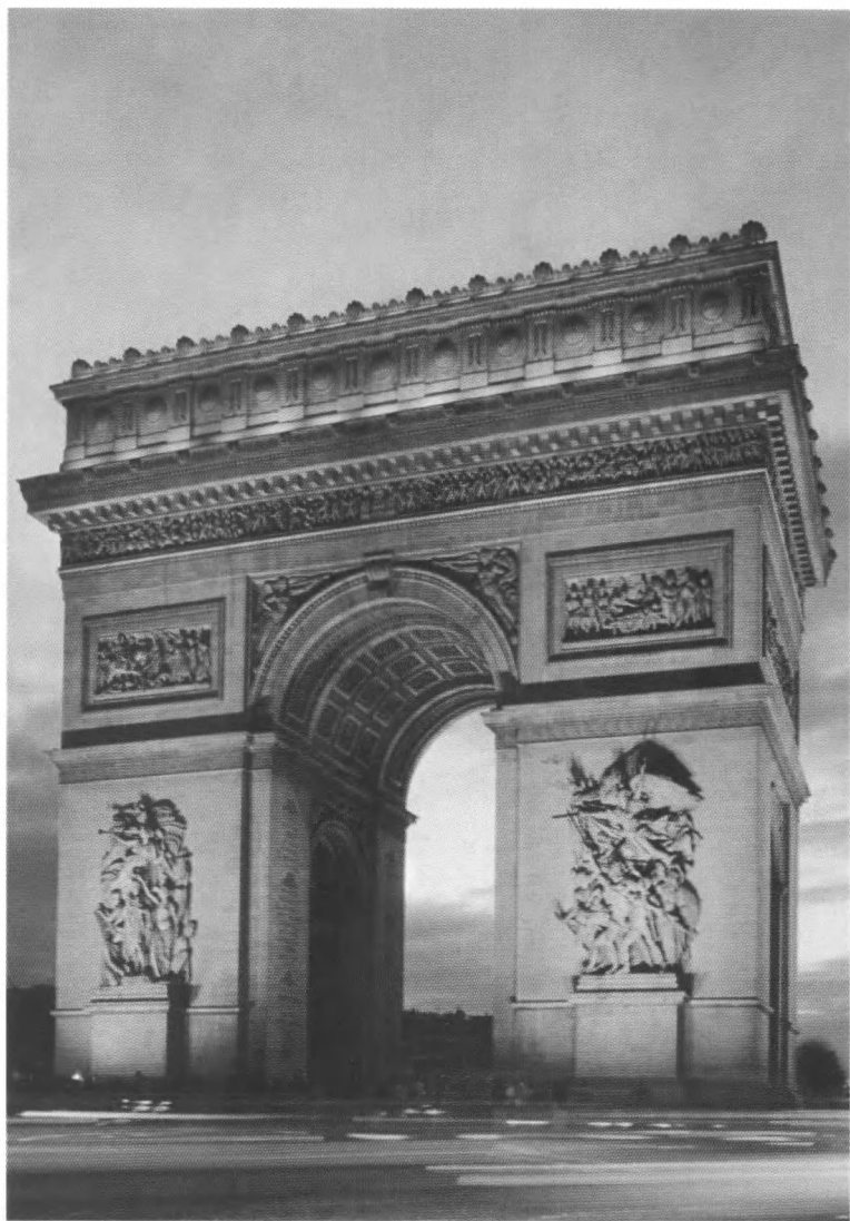
Арка на площади Звезды. 1806—1836. Ж. Ф. Шальгрен и др. В 1970 году переименована в площадь Шарля де Голля. Современное фото.
