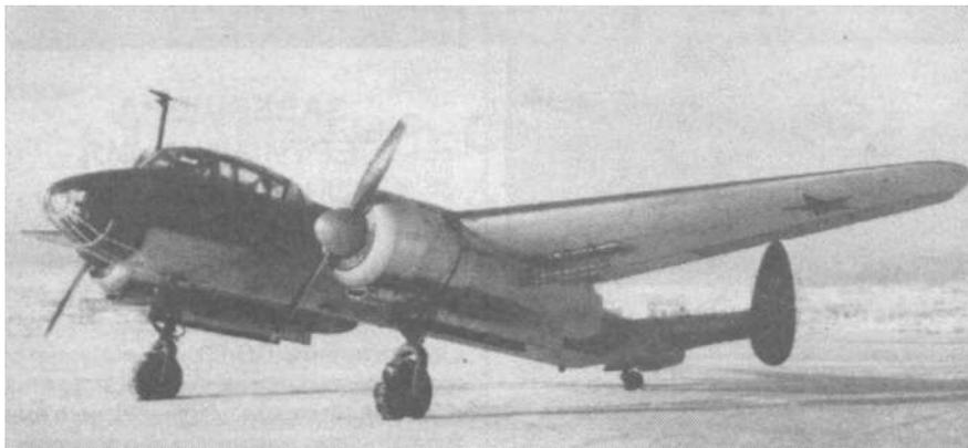
*УТБ в варианте пикирующего бомбардировщика на заводских испытаниях. Под крылом видны выпущенные тормозные решетки.*
