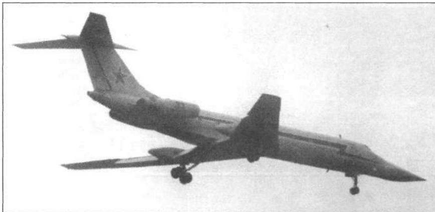
Ту-134УБЛ в воздухе и на земле. Характерной особенностью машины является носовая часть с обтекателем антенны РЛС, применяемой на Ту-22М.
