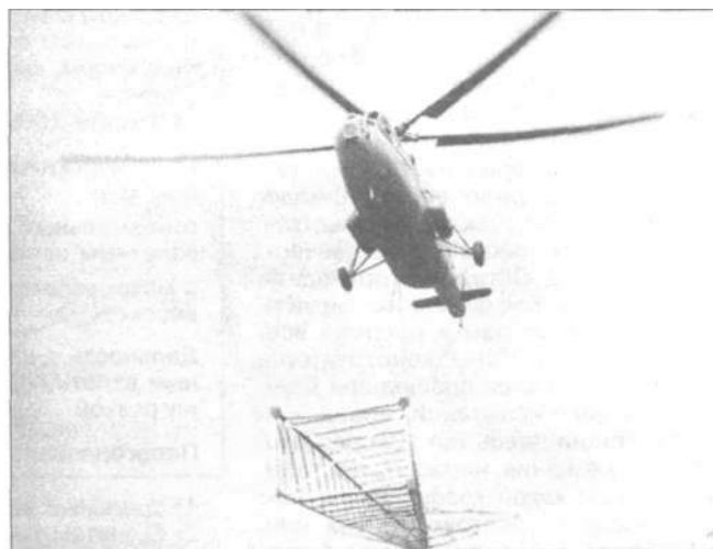
Ми-6 со снятым крылом переносит мачту ЛЭП.
