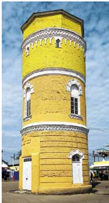
Водонапорная башня около ж/д станции Михнево, Московская обл.
