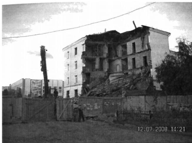
Рис. 3. Разрушение здания геологического управления в г. Якутске при оттаивания пород основания. Фото С.И. Серикова.
