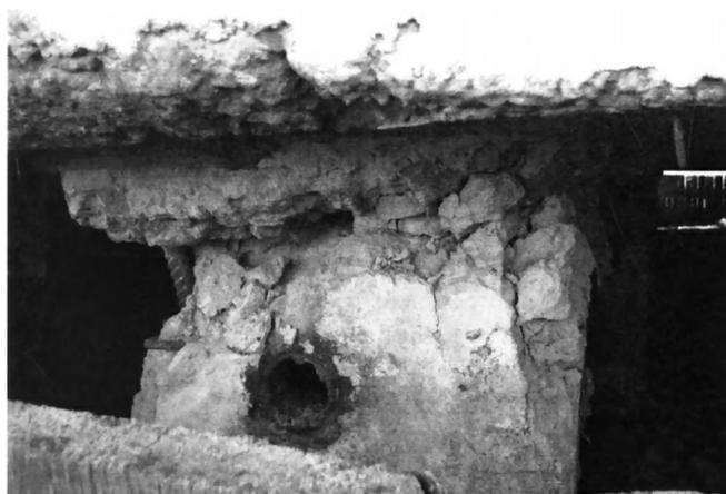
Рис. 4. Разрушение сваи пятиэтажного здания в г. Якутске. Фото С.И. Серикова.
