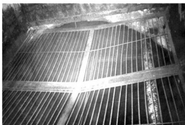
Рис. 2. Негативные проявления горного давления вблизи скипового ствола на руднике «Интернациональный» (горизонт №6, Н = 801 м):
