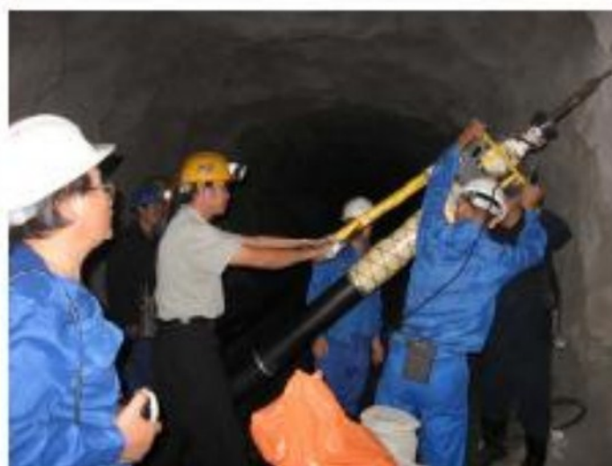
Рис.4. Набрызгбетонная крепь
