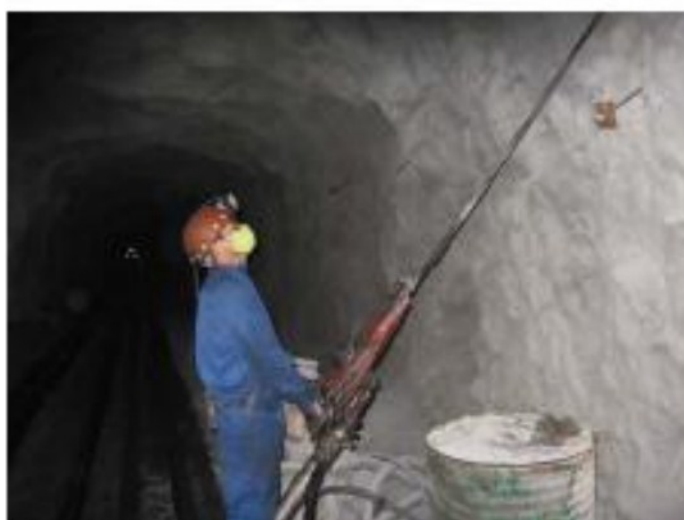
Рис.4. Набрызгбетонная крепь
