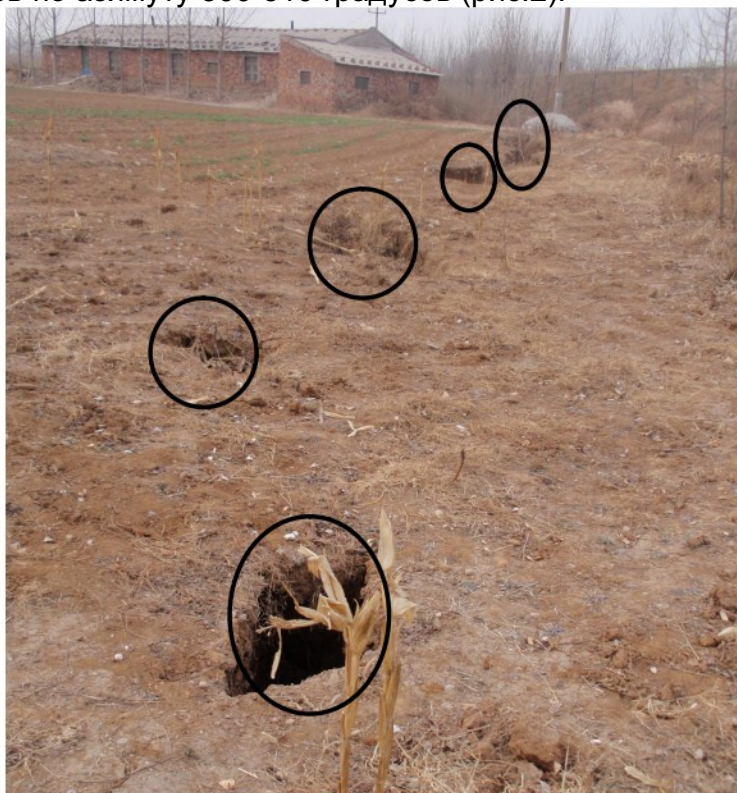
Рис.2. Фрагменты трещины на поверхности шахтного поля
