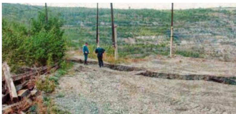
**Рис.3. Трещина отрыва в зоне влияния деформируемого борта Коркинского разреза**
