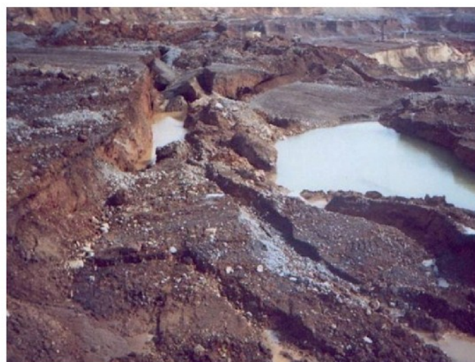
Рис. 1. Деформационные процессы на карьере месторождения «Подотвальное»
