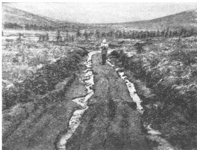
Рис. 68. Тракторная дорога на склоне, по которой идет термоэрозия.
