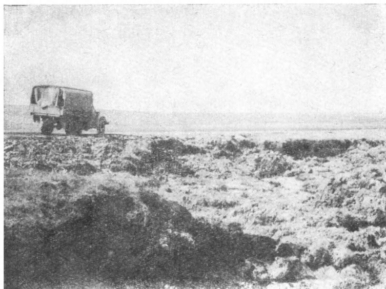
Рис. 50. Термоэрозия грозит устойчивости дороги.
