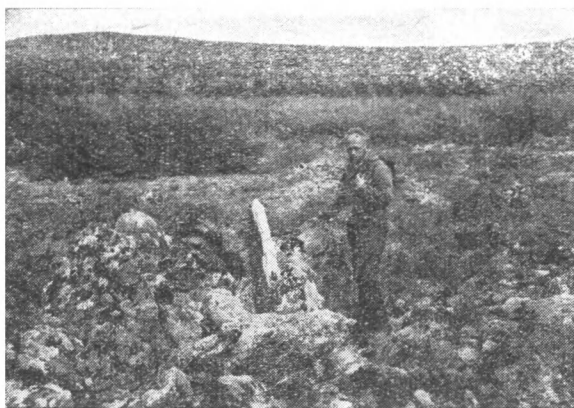
Рис. 31. Выпучивание камней и образование каменной россыпи у подножия склона на Становом нагорье недалеко от трассы БАМа.
