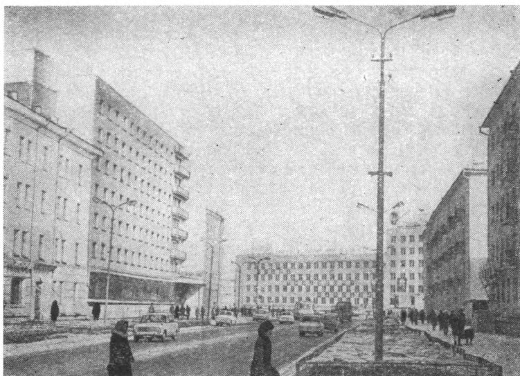
Рис. 64. Центр Якутска. Все здания построены на сваях по принципу сохранения мерзлого состояния грунтового основания. (Фото И. А. Некрасова.)
