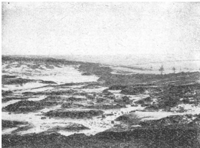
Рис. 69. Поверхность «ледового комплекса», вскрытая бульдозерами. Из-под мохово-растительного покрова начинается протаивание ледяных жил и образование байджерахов.
