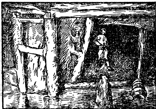
Рис. 6. Шахта с бетонированными креплениями.
