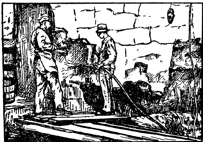
Рис. 5. Заделка пневматическим бетоном осыпавшейся кладки при помощи портативного ручного аппарата.
