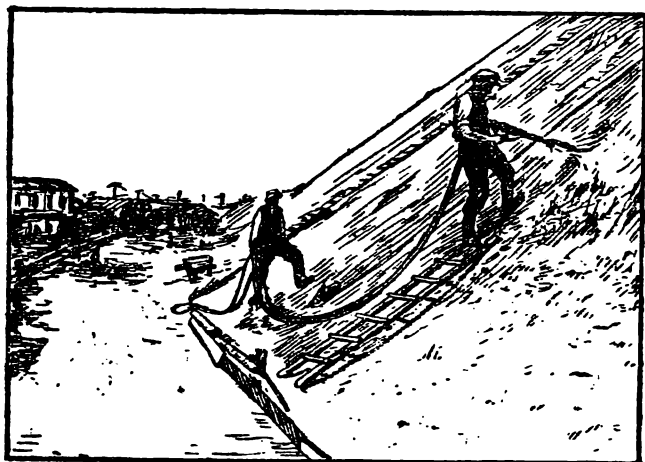
Рис. 4. Накладывание слоя цементной штукатурки на „тощий“ бетон русла канала.
