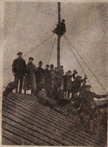
Радио-мачта, установленная на здании Центрального Межсоюзного Рабочего Клуба в г. Сталине радио-кружком клуба.
