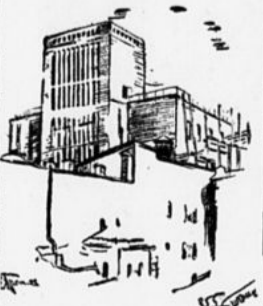
Строится здание Института Ленина.
