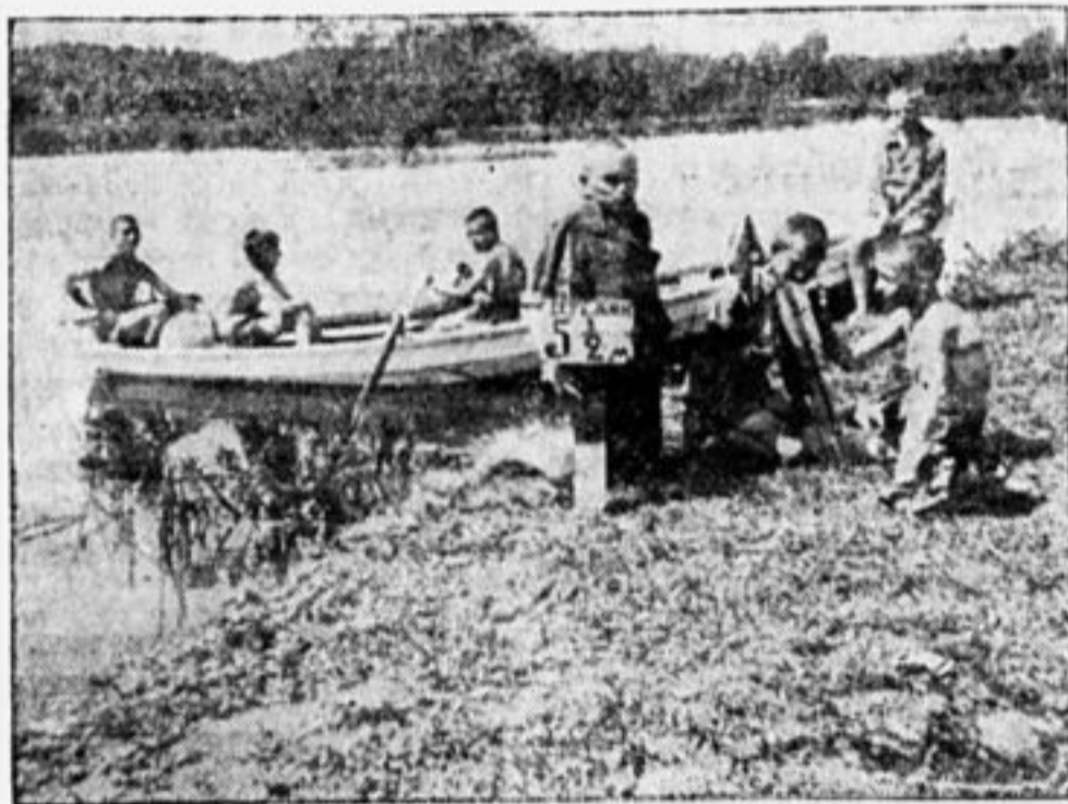
УСТАНОВКА СТОЛБИКА С ПРОМЕРОМ ПРУДА.
