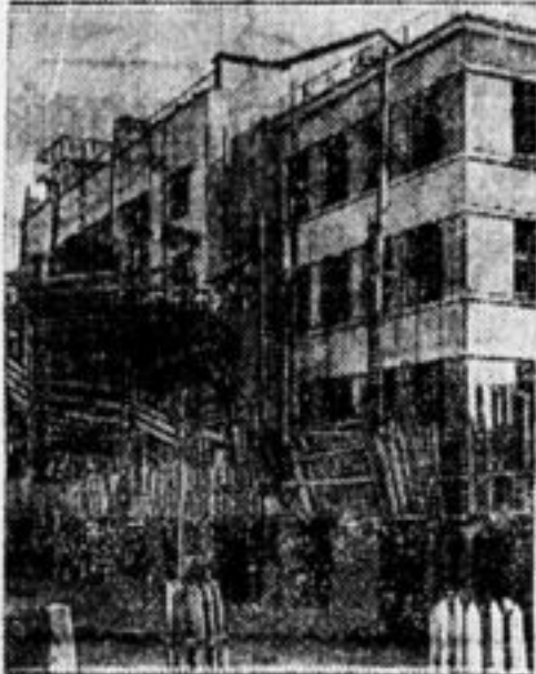
Заканчивается постройка школьного городка им. 10-летия Октябрьской революции. Главный корпус школы.
