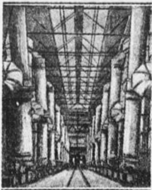
Общий вид водородного цеха азотного завода Леуна (Германия).
