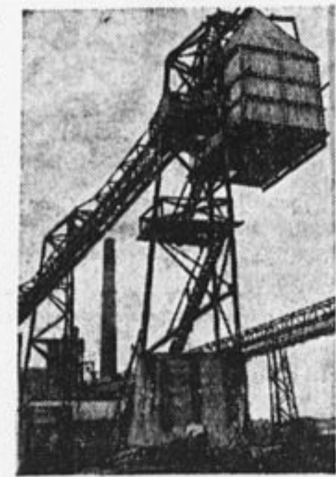
Брянский завод «Профинтерн». Пути для доставки угля в котельные электростанции.
