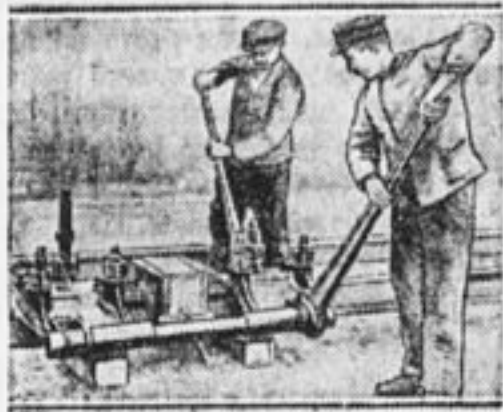
Стягивание стыка зажимным аппаратом.
