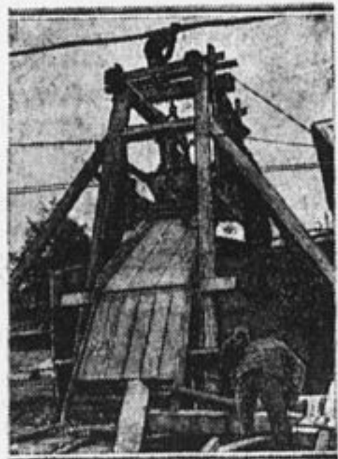
Постройка новых артезианских колодцев на станц. Цементная.
