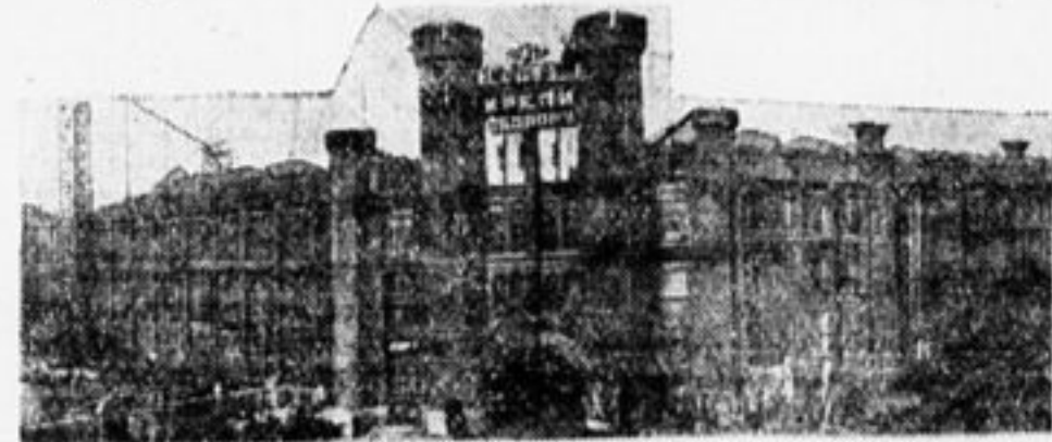
Общий вид электротехнического завода.
